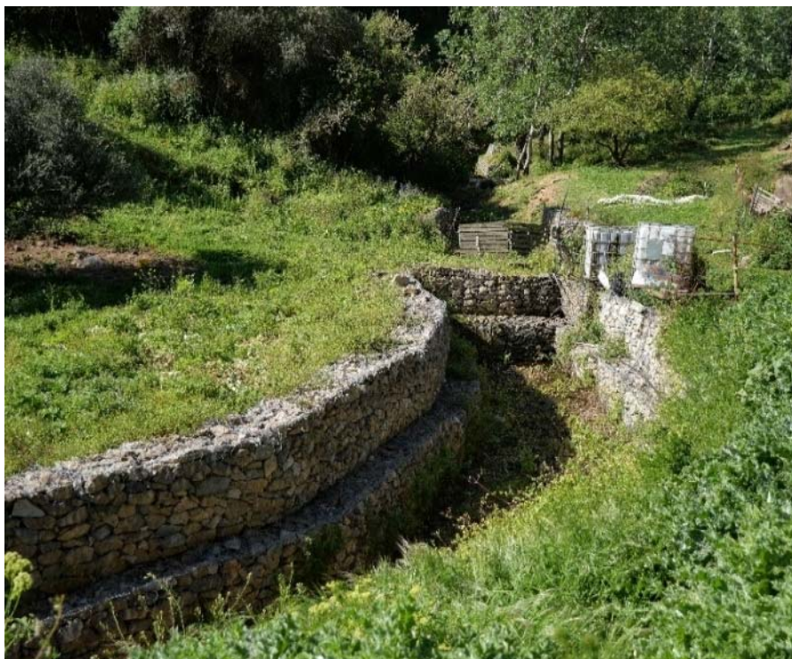
Fig. 9: Interventi di sistemazione spondale e briglie nel Rio di Tula
