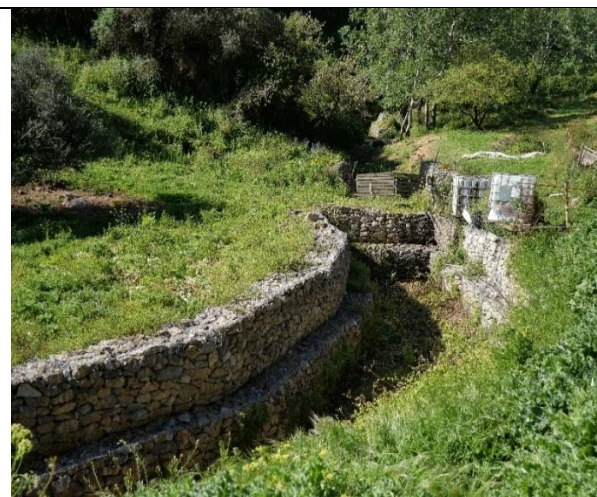
Fig. 20: Interventi di sistemazione spondale e briglie nel Rio di Tula
