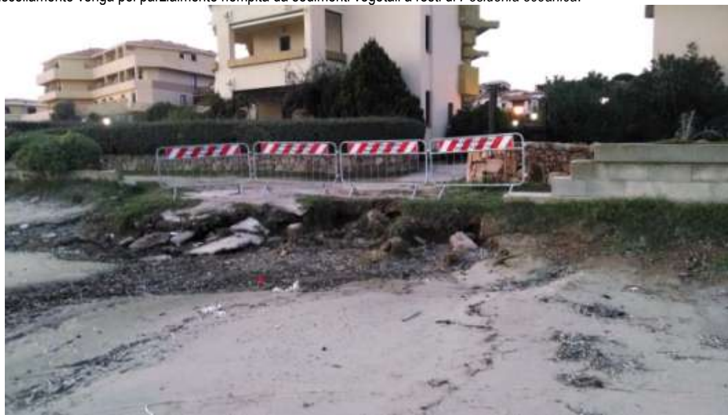
Fig. 26 - Erosione incanalata (caso 2 di Fig. 8B). vista frontale dalla spiaggia. Il processo interessa la spiaggia e la base artificiale dello stradello che la contorna
