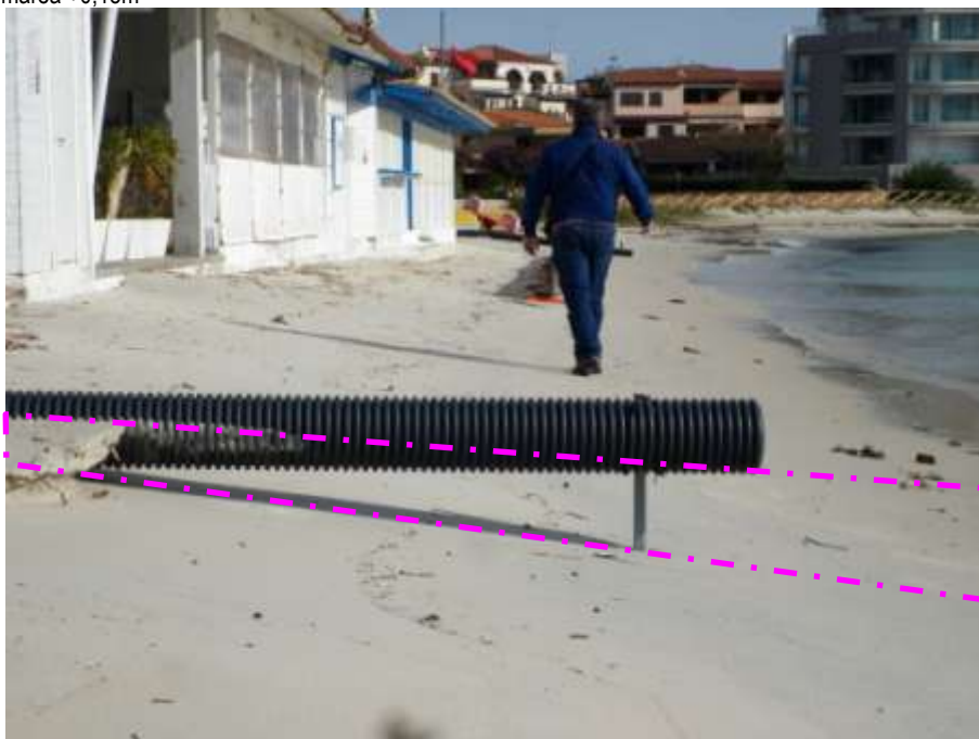
Fig. 24 - Stato della berma e della battigia il 16 Novembre 2017, ore 14:19, marea +0,15m. In evidenza le soluzioni provvisorie di drenaggio adottate a prevenzione di danneggiamenti e lo spessore (circa 15cm al sostegno) della sezione volumetrica sottratta tempo per ondazione rispetto al profilo di bel nel corso di eventi sciroccali del mese di Ottobre.
