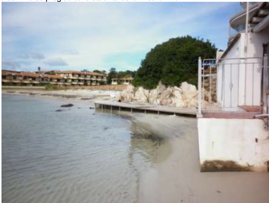
Fig. 32 - Estremità Est-NordEst della falcata sabbiosa con lo strutturale stato di arretramento della battigia in prossimità di sostrato roccioso affiorante e di strutture rigide dell'albergo
