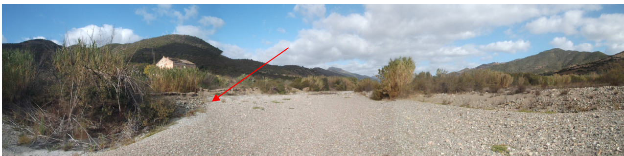
Panorama.2 La vista evidenzia che i fenomeni erosivi, avvenuti durante le piene, si sono verificati lungo la sponda ovest del Rio Quirra, sul lato della SS 125. In alcuni casi il livello dell'acqua ha raggiunto la sede stradale, causando l'interruzione del traffico.
