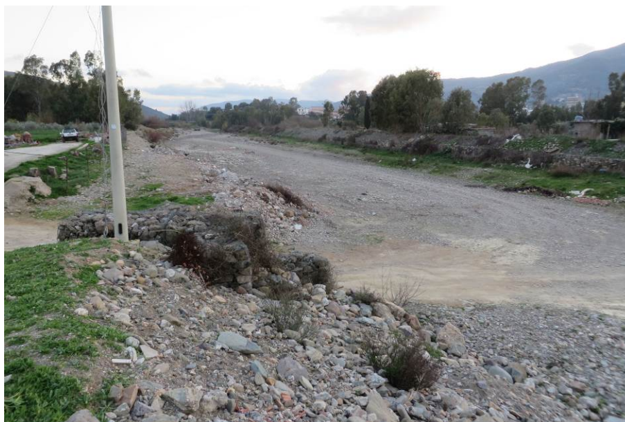
Figura 63 - Guado a raso con accesso ottenuto tramite l'interruzione della protezione spondale (23s)
