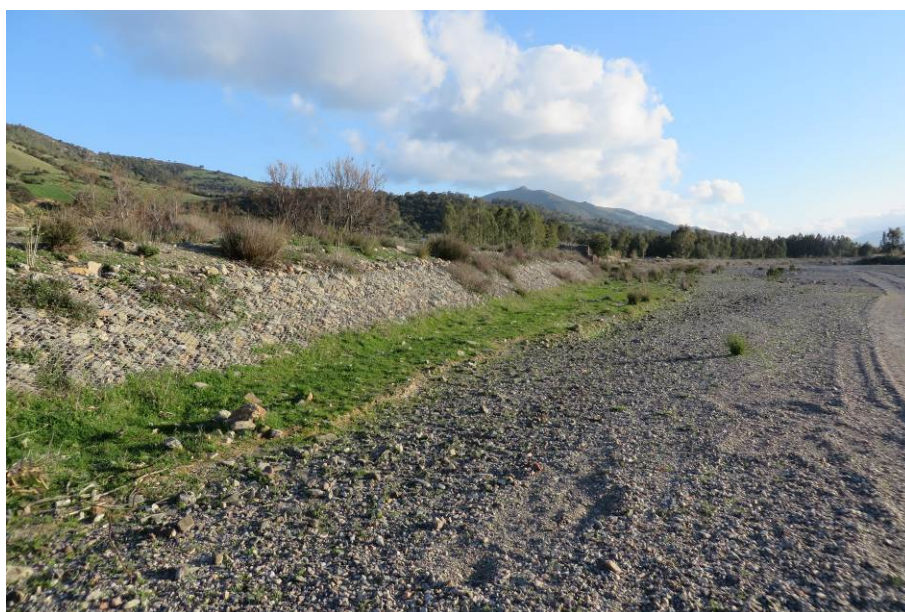
Figura 46 - Protezione spondale esistente realizzata con materassi metallici riempiti con pietrame (6s)
