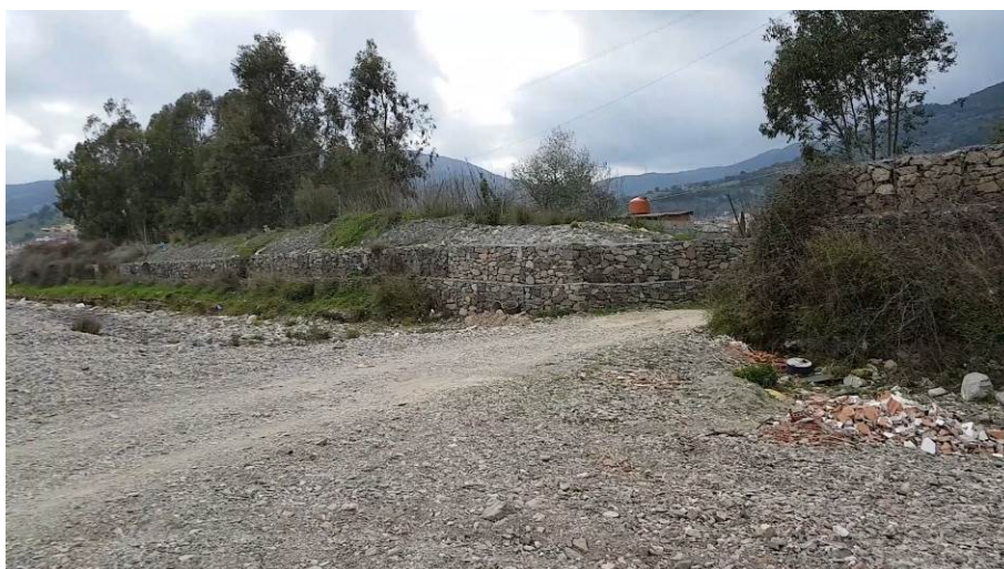
Figura 24 - Guado a raso con accessi ottenuti tramite l'interruzione della protezione spondale (24d)
