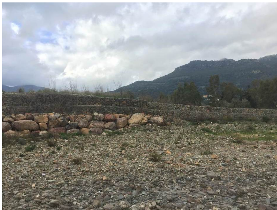
Figura 14 - Stabilizzazione al piede della protezione spondale esistente realizzata massi ciclopici (14d)
