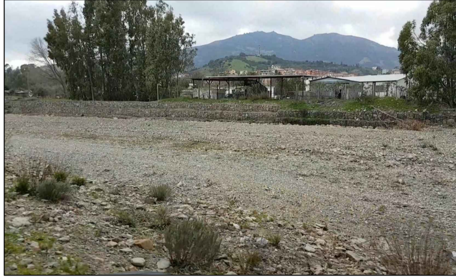
27d - Protezione spondale in gabbioni metallici riempiti in pietrame
