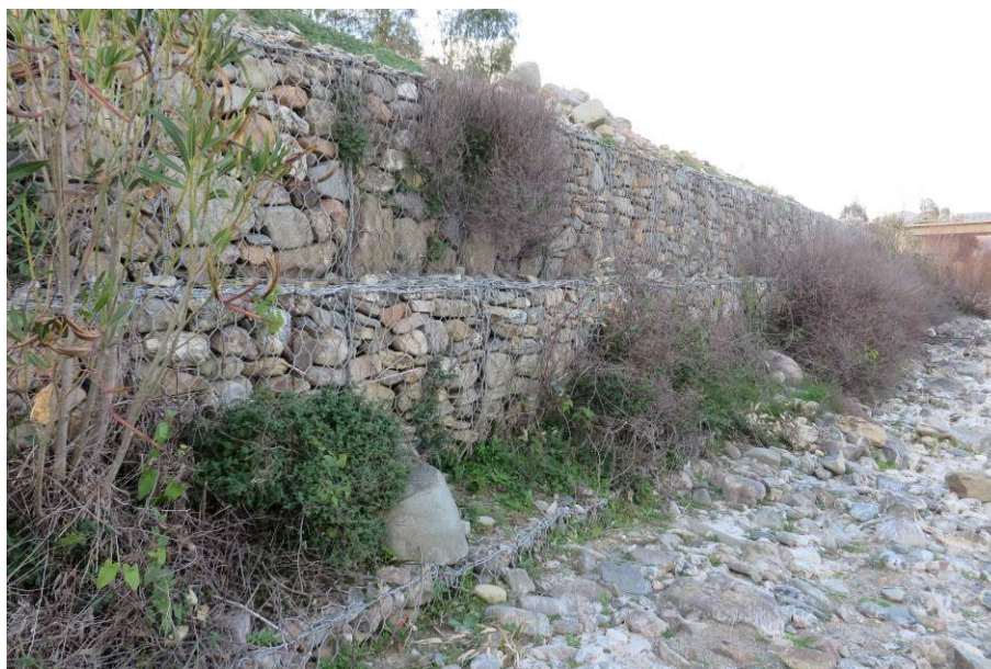
Figura 3 - Protezione spondale esistente realizzata con gabbioni metallici riempiti con pietrame (3d)
