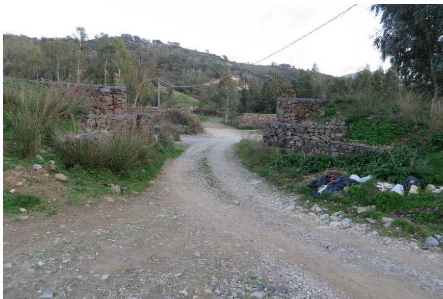
Figura 21 - Guado a raso con accessi ottenuti tramite l'interruzione della protezione spondale (21d)
