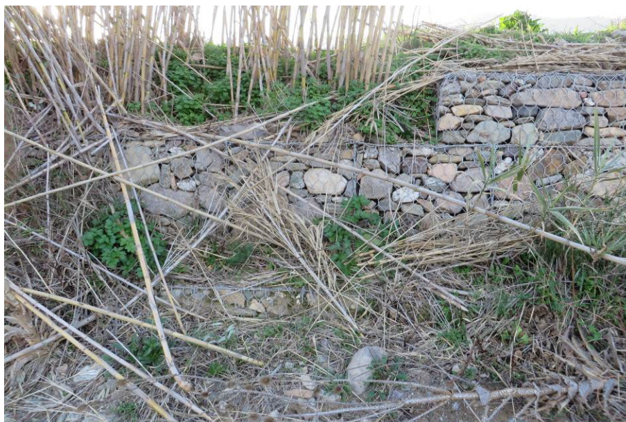
Figura 5 - Cambio sezione della protezione spondale realizzata con gabbioni metallici riempiti con pietrame (5d)
