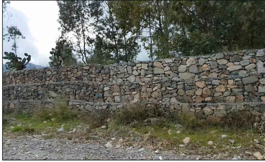
23d - Protezione spondale esistente realizzata con gabbioni metallici riempiti con pietrame
