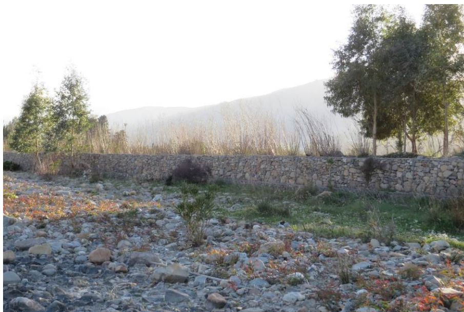
Figura 7 - Protezione spondale esistente realizzata con gabbioni metallici riempiti con pietrame (7d)
