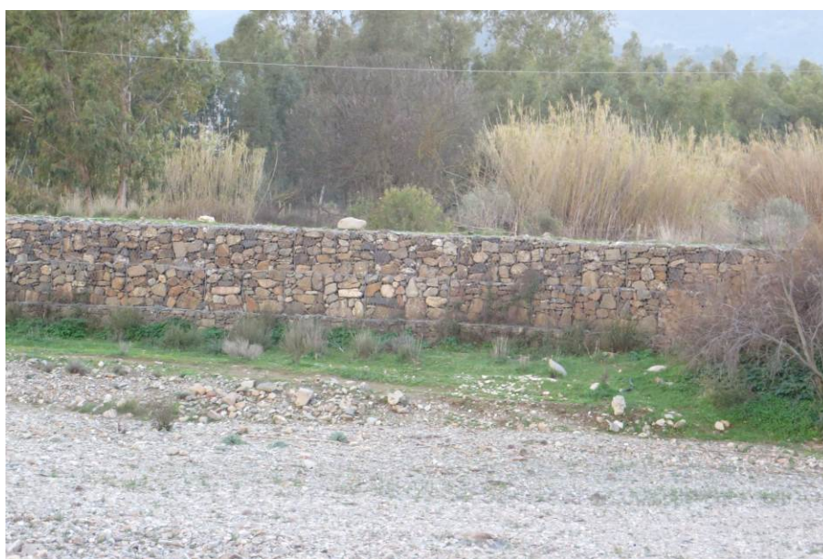
Figura 16 - Protezione spondale esistente realizzata con gabbioni metallici riempiti con pietrame (16d)
