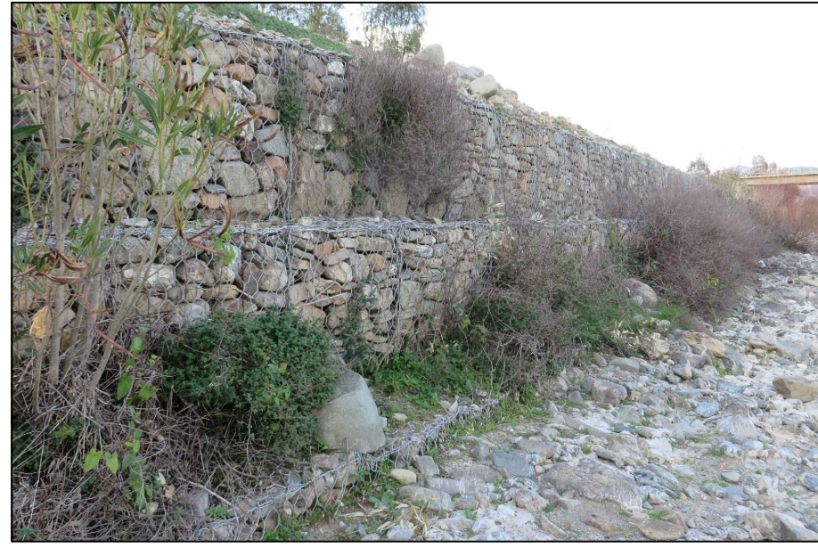
3d - Protezione spondale esistente realizzata con gabbioni metallici riempiti con pietrame
