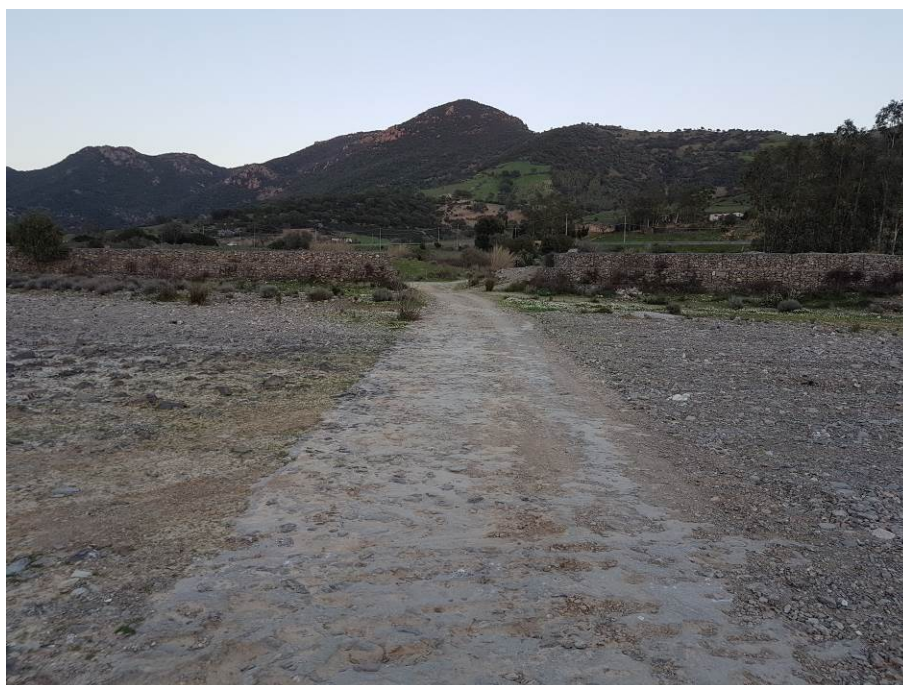
Figura 48 - Guado a raso con accesso ottenuto tramite l'interruzione delle protezione spondale (8s)
