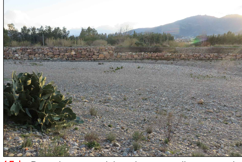
15d - Protezione spondale esistente realizzata tramite scogliera in massi ciclopici
