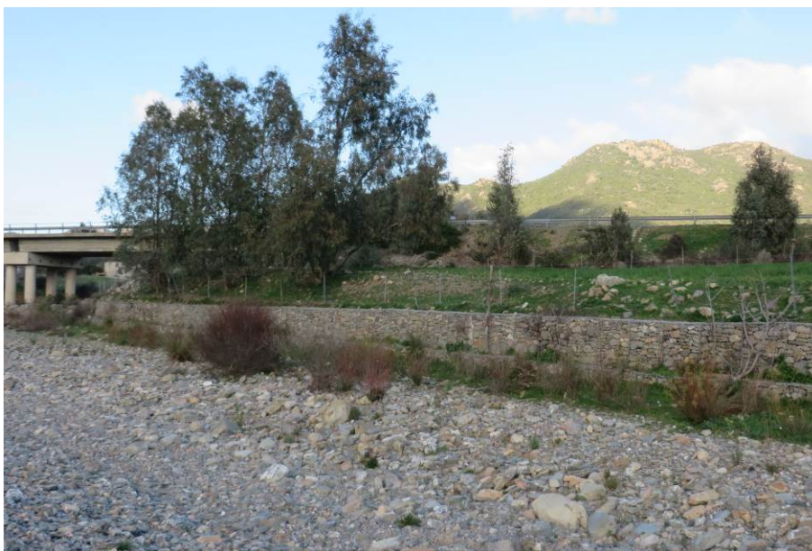
Figura 42 - Protezione spondale esistente realizzata con gabbioni metallici riempiti con pietrame (2s)
