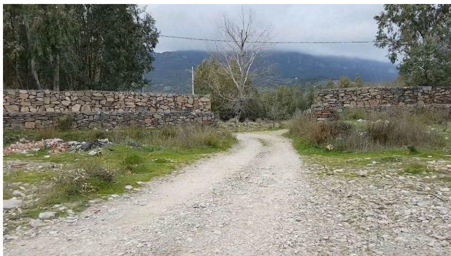
Figura 22 - Guado a raso con accessi ottenuti tramite l'interruzione della protezione spondale (22d)
