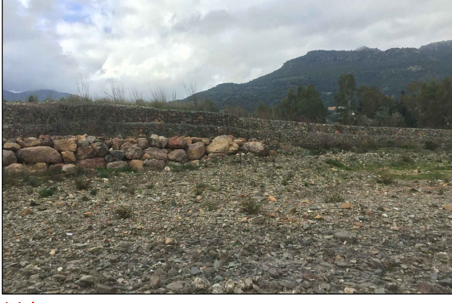
14d - Stabilizzazione al piede della protezione spondale esistente realizzata massi ciclopici
