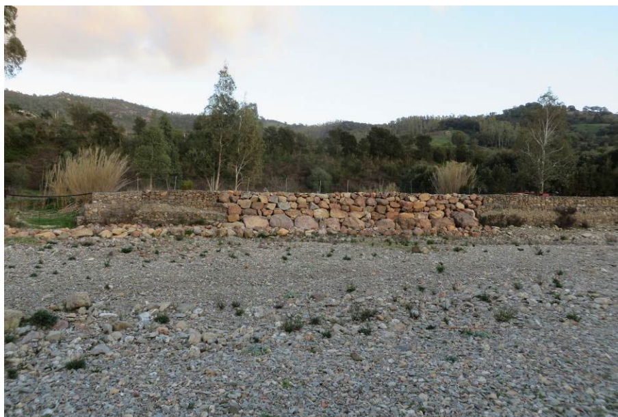
Figura 58 - Tratto di protezione spondale realizzata tramite scogliera in massi ciclopici (18s)
