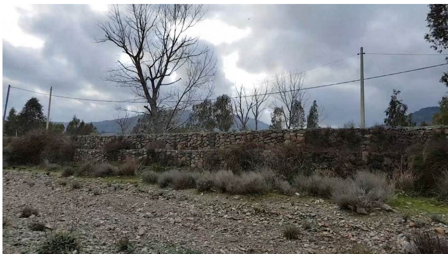
Figura 20 - Protezione spondale esistente realizzata con gabbioni metallici riempiti con pietrame (20d)
