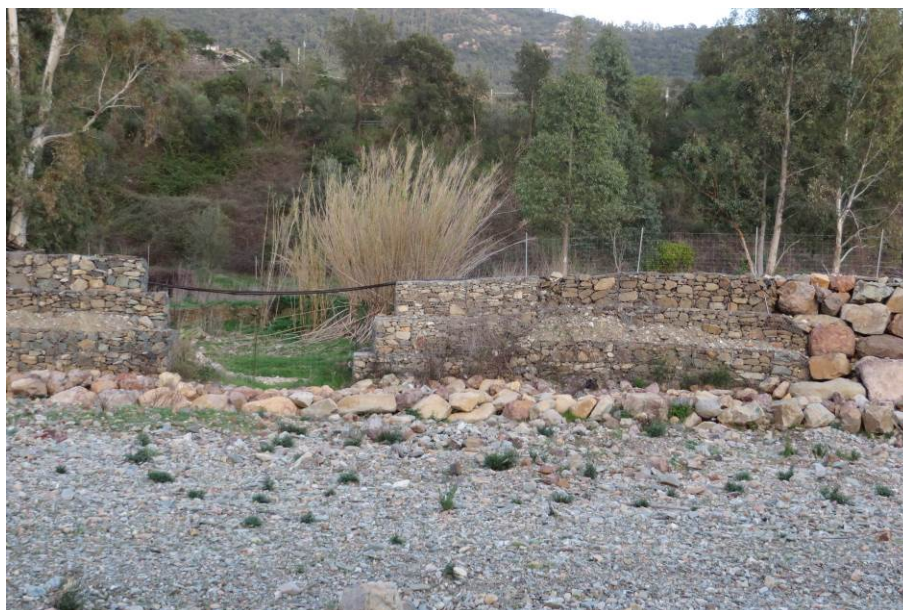
Figura 57 - Immissione a raso dell'impluvio laterale (17s)
