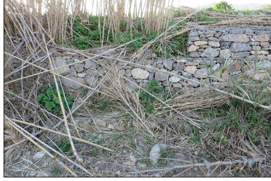
5d - Cambio sezione della protezione spondale realizzata con gabbioni metallici riempiti con pietrame
