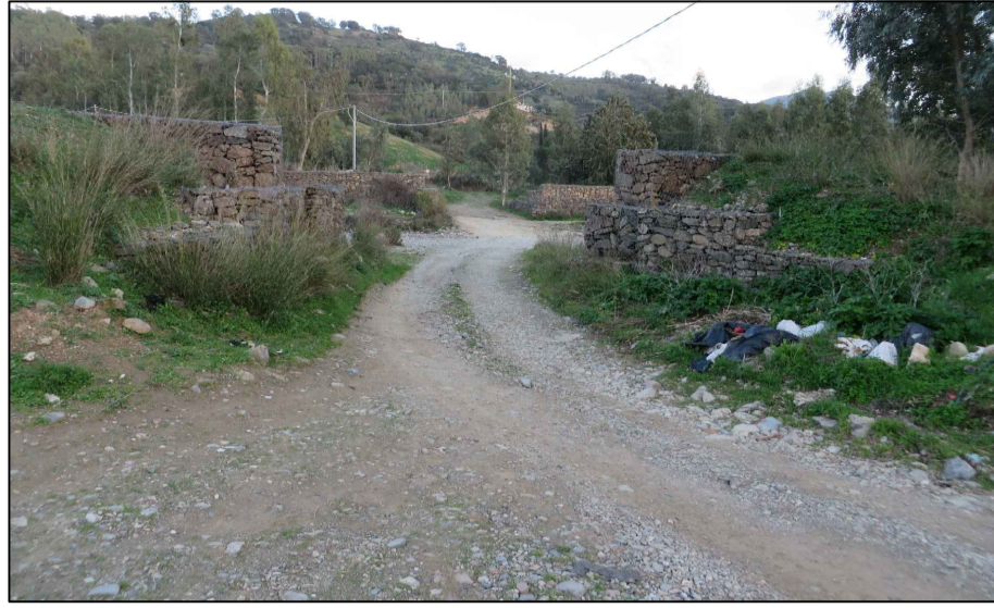
21d - Guado a raso con accessi ottenuti tramite l'interruzione della protezione spondale
