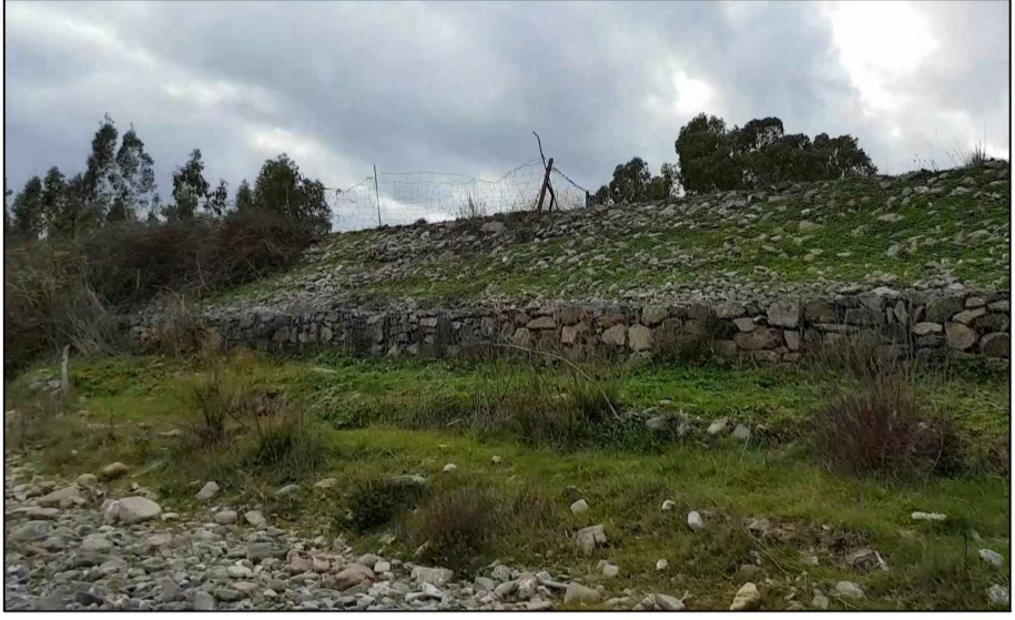
30d - Protezione spondale con soluzione mista gabbioni/materassi metallici riempiti in pietrame
