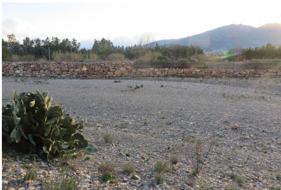
Figura 15 - Protezione spondale esistente realizzata tramite scogliera in massi ciclopici (15d)
