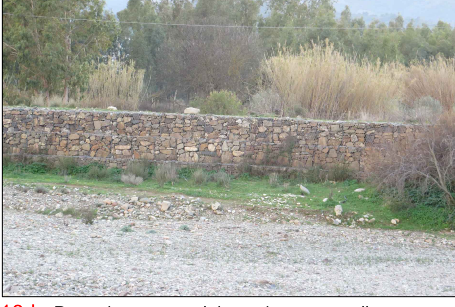
16d - Protezione spondale esistente realizzata con gabbioni metallici riempiti con pietrame
