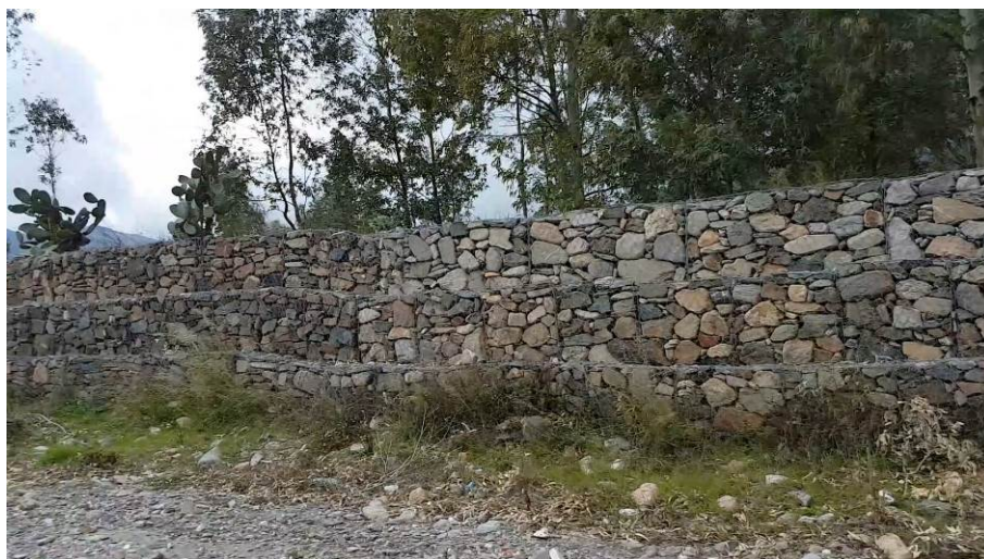
Figura 23 - Protezione spondale esistente realizzata con gabbioni metallici riempiti con pietrame (23d)
