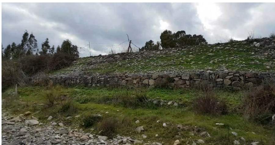
Figura 30 - Protezione spondale con soluzione mista gabbioni/materassi metallici riempiti in pietrame (30d)
