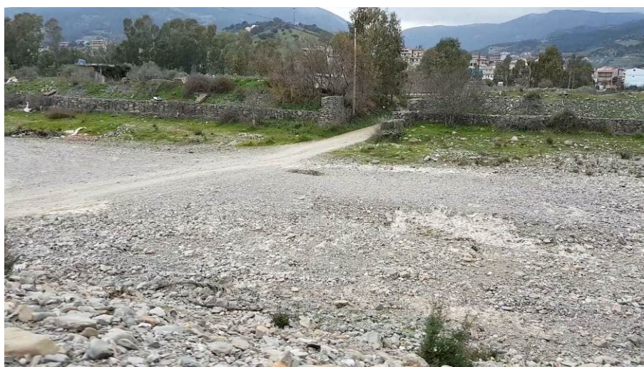
Figura 28 - Guado a raso con accessi ottenuti tramite l'interruzione della protezione spondale (28d)
