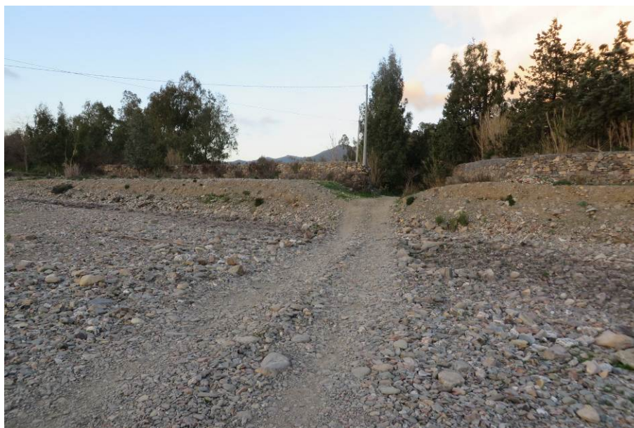
Figura 56 - Guado a raso con accesso ottenuto tramite l'interruzione delle protezione spondale (16s)
