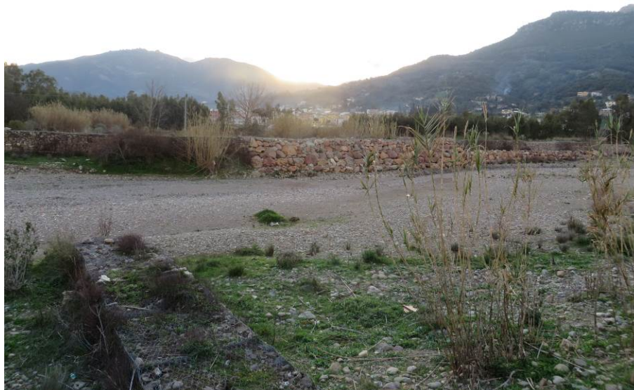
Figura 55 - Pennelli esistenti in gabbioni metallici riempiti in pietrame (15s)
