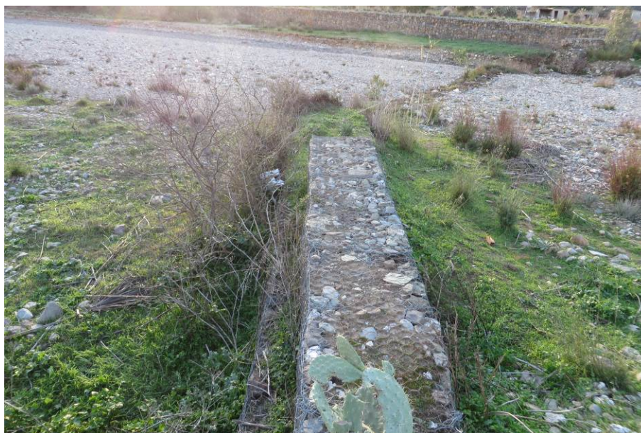
Figura 53 - Pennello esistente in gabbioni metallici riempiti in pietrame (13s)
