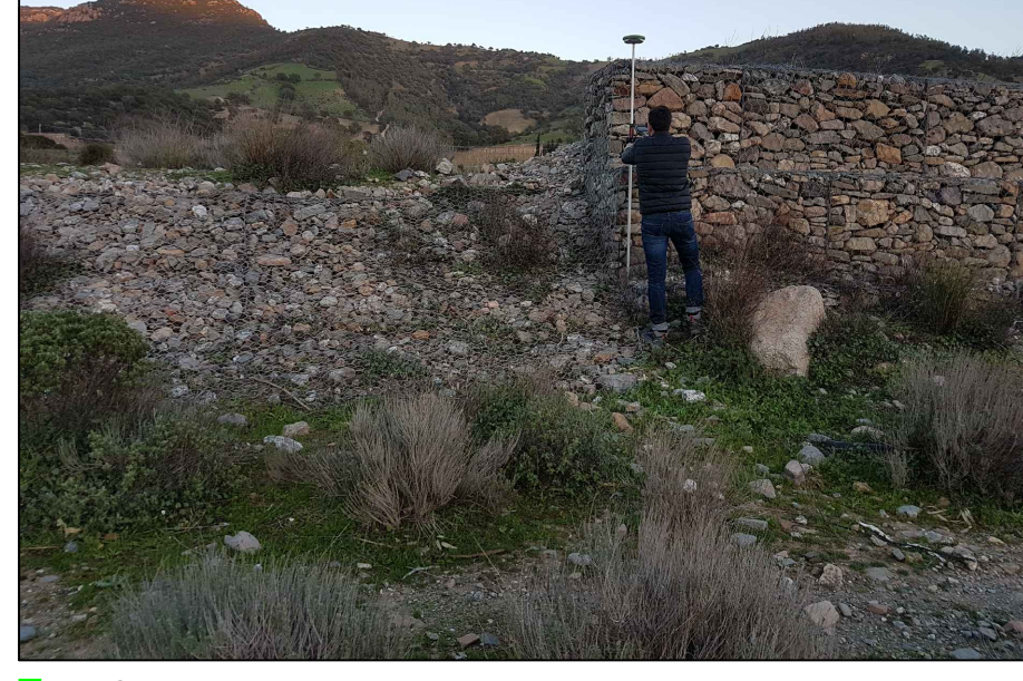
7s - Cambio sezione della protezione spondale realizzata con gabbioni/materassi metallici riempiti con pietrame
