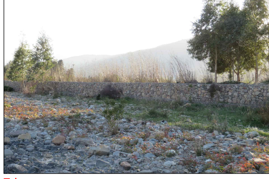
7d - Protezione spondale esistente realizzata con gabbioni metallici riempiti con pietrame
