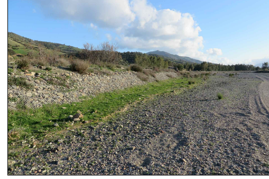
6s - Protezione spondale esistente realizzata con materassi metallici riempiti con pietrame
