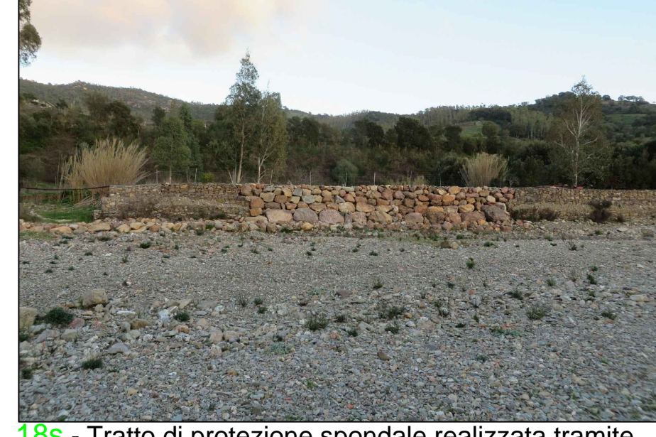
18s - Tratto di protezione spondale realizzata tramite scogliera in massi ciclopici
