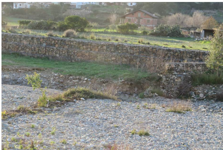
Figura 12 - Protezione spondale e opere di stabilizzazione trasversale esistenti realizzati con gabbioni metallici riempiti con pietrame (12d)
