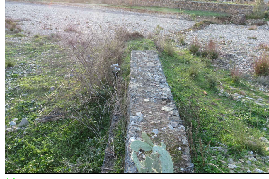
13s - Pennello esistente in gabbioni metallici riempiti con pietrame
