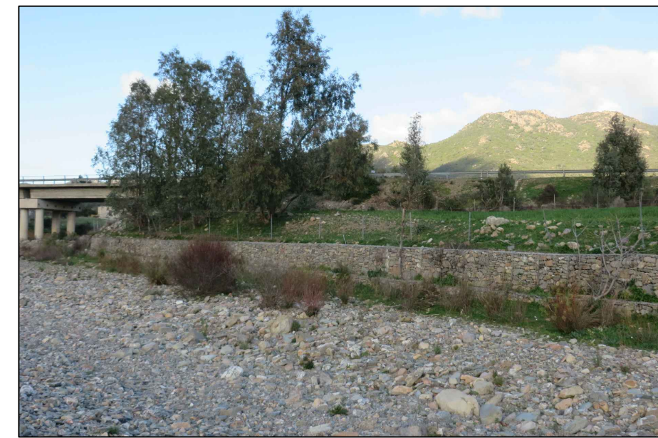
2s - Protezione spondale esistente realizzata con gabbioni metallici riempiti con pietrame
