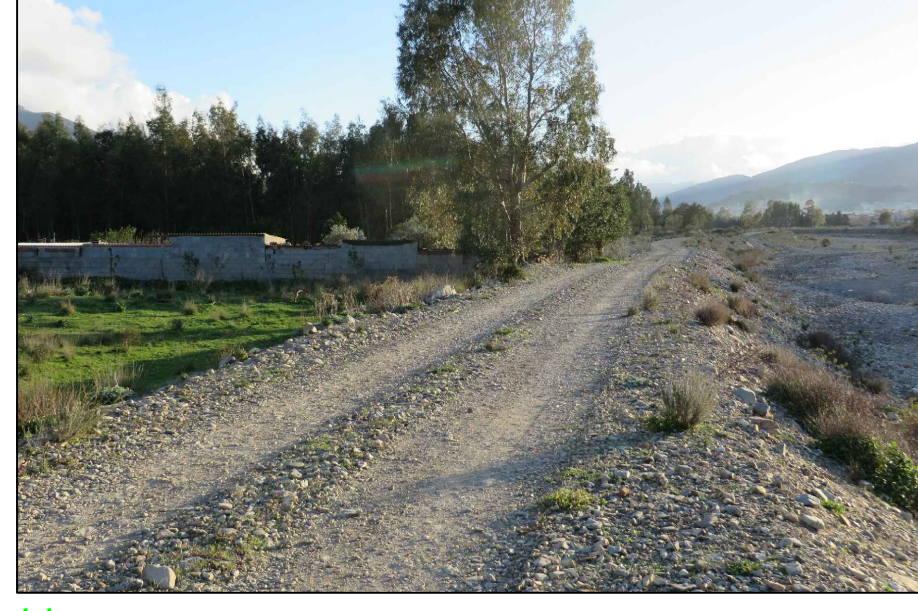
11s - Vista dell'argine in materiale incoerente
