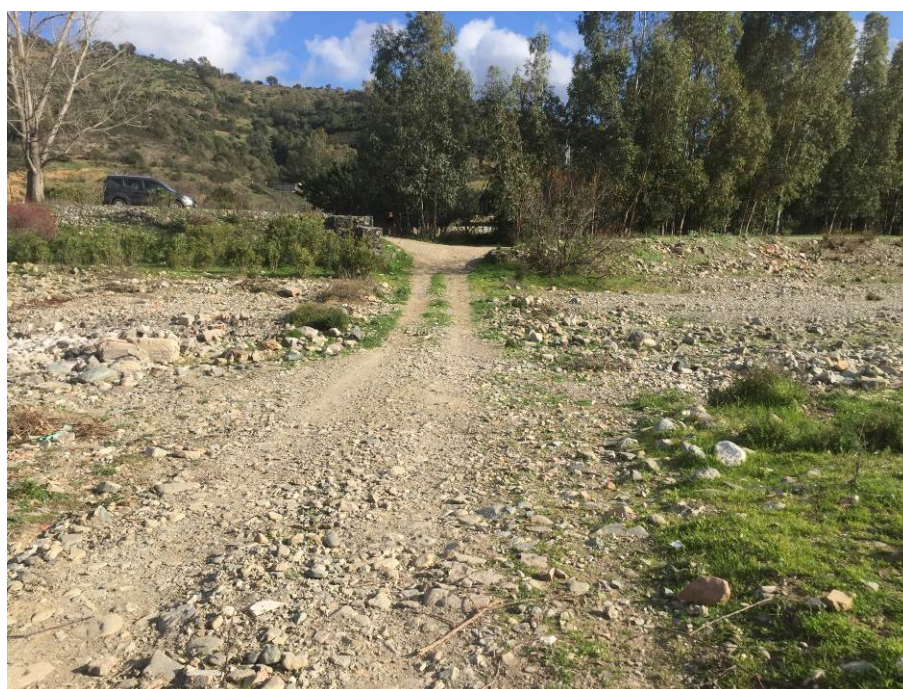
Figura 60 - Guado a raso con accesso ottenuto tramite l'interruzione della protezione spondale (20s)
