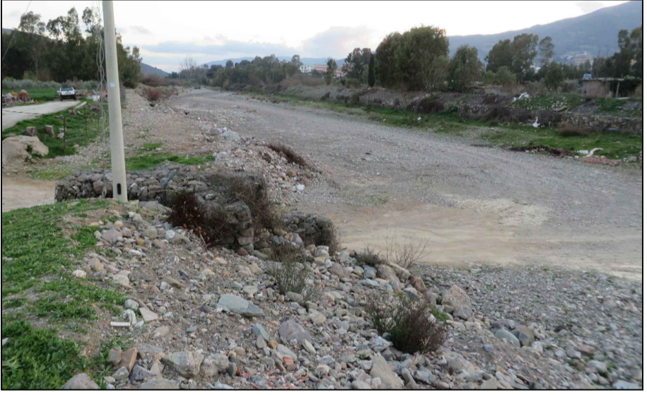
23s - Guado a raso con accesso ottenuto tramite l'interruzione della protezione spondale
