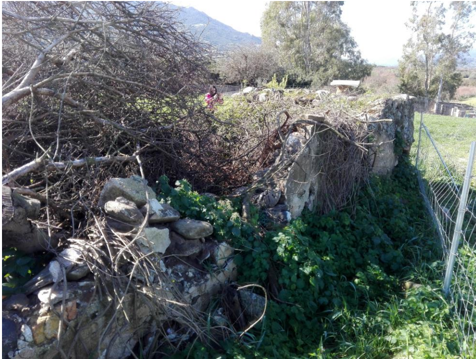
Ruderi della chiesa di San Giuseppe di Isalle, lato ovest
