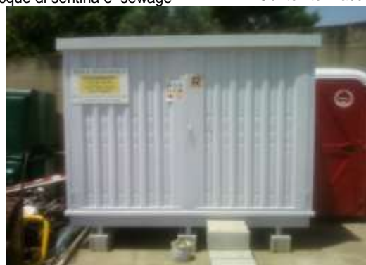
Area attrezzata per raccolta filtri, imballaggi e accumulatori
