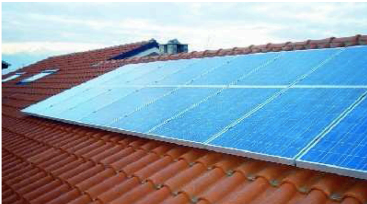
Figura 14: Esempio di pannelli fotovoltaici montati a tetto senza l'impiego di supporti particolarmente impattanti
