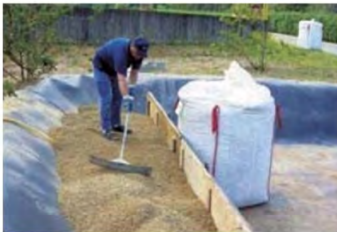
Fig 3: riempimento del vascone con mix di zeoliti naturali debitamente trattate e calibrate.
