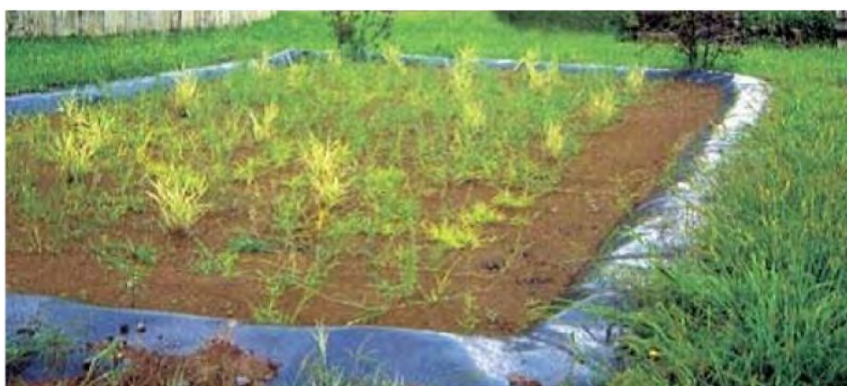
Fig 5: vascone con messa a dimora delle piante micorrizate "Phragmites Australis".
