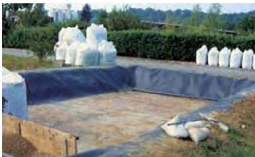
Fig 2: vascone, parzialmente incassato nel terreno rivestito con telo in geotessile e successiva guaina in HDPE dello spessore di 2 mm.
