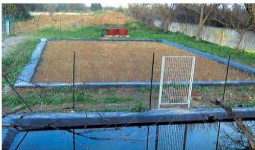
Fig 4: vascone pronto per la piantumazione delle diverse essenze vegetali macrofite atte alla depurazione.
