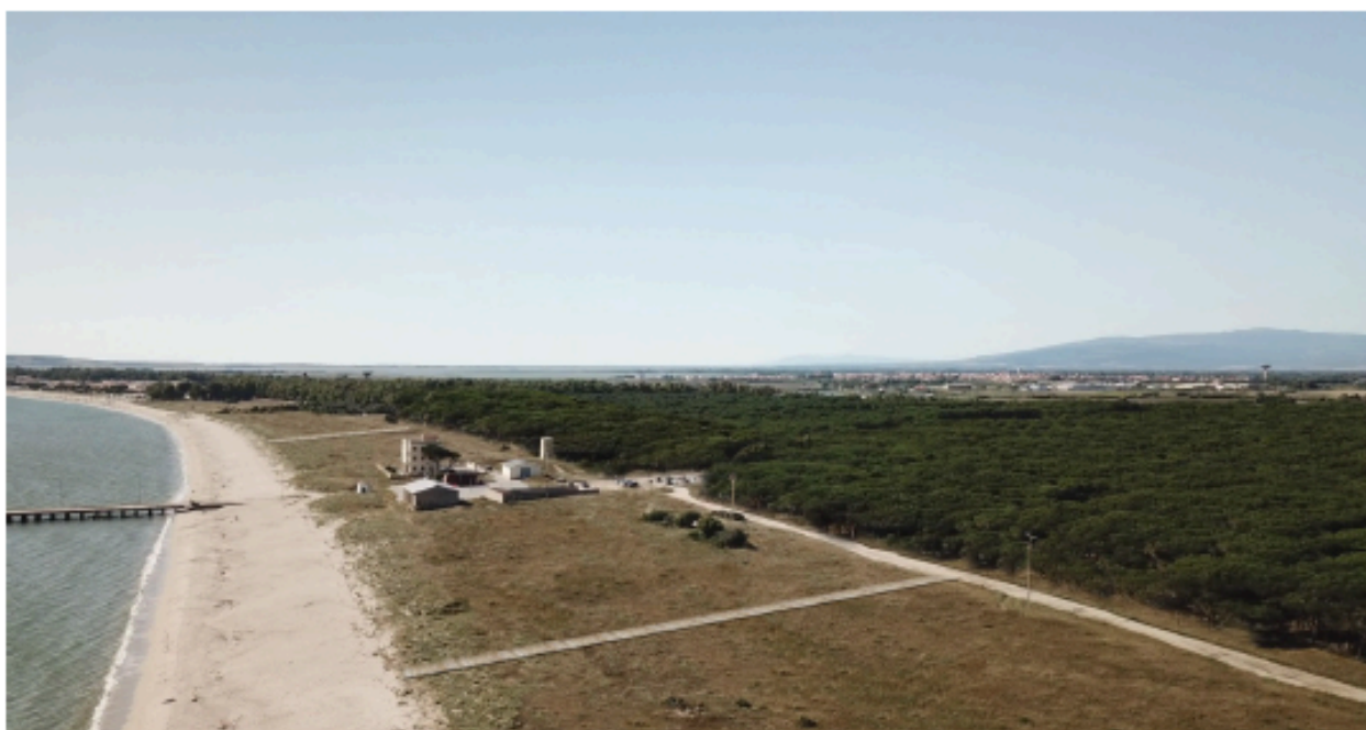
Figura 19 - vista post intervento dell'area dunale con evidente razionalizzazione dei percorsi.
