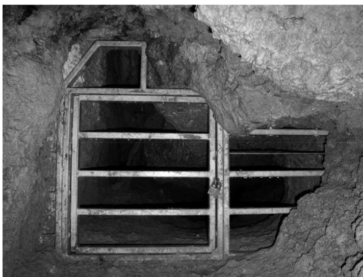
Fig. 24 Esempio di cancello per l'ingresso superiore della grotta n.0028
