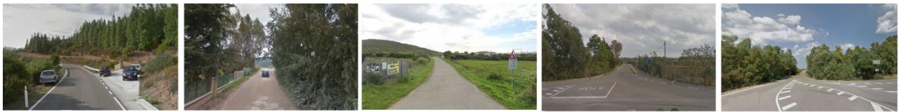
7_Porta FD Usinavà sud, SP67, Torpè
