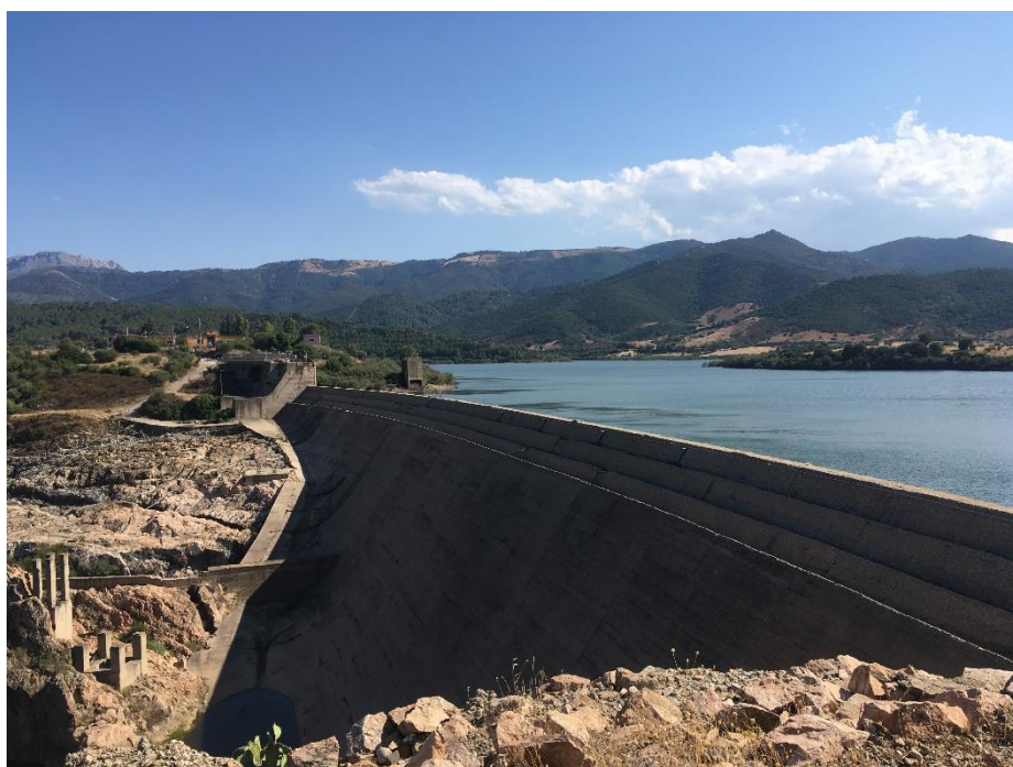
Figura 15a,b: Viabilità provinciale da ripristinare al termine dei lavori di sovrizzo della diga e indicazione del marciapiede (sopra); vista del Lago artificiale Maccheronis dallo sbarramento (sotto)
