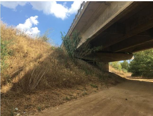
Fig. 18: Sottopassaggio in corrispondenza del ponte della SS_131 DCN che attraversa il Rio Posada. Fotografia di Mara Ladu
