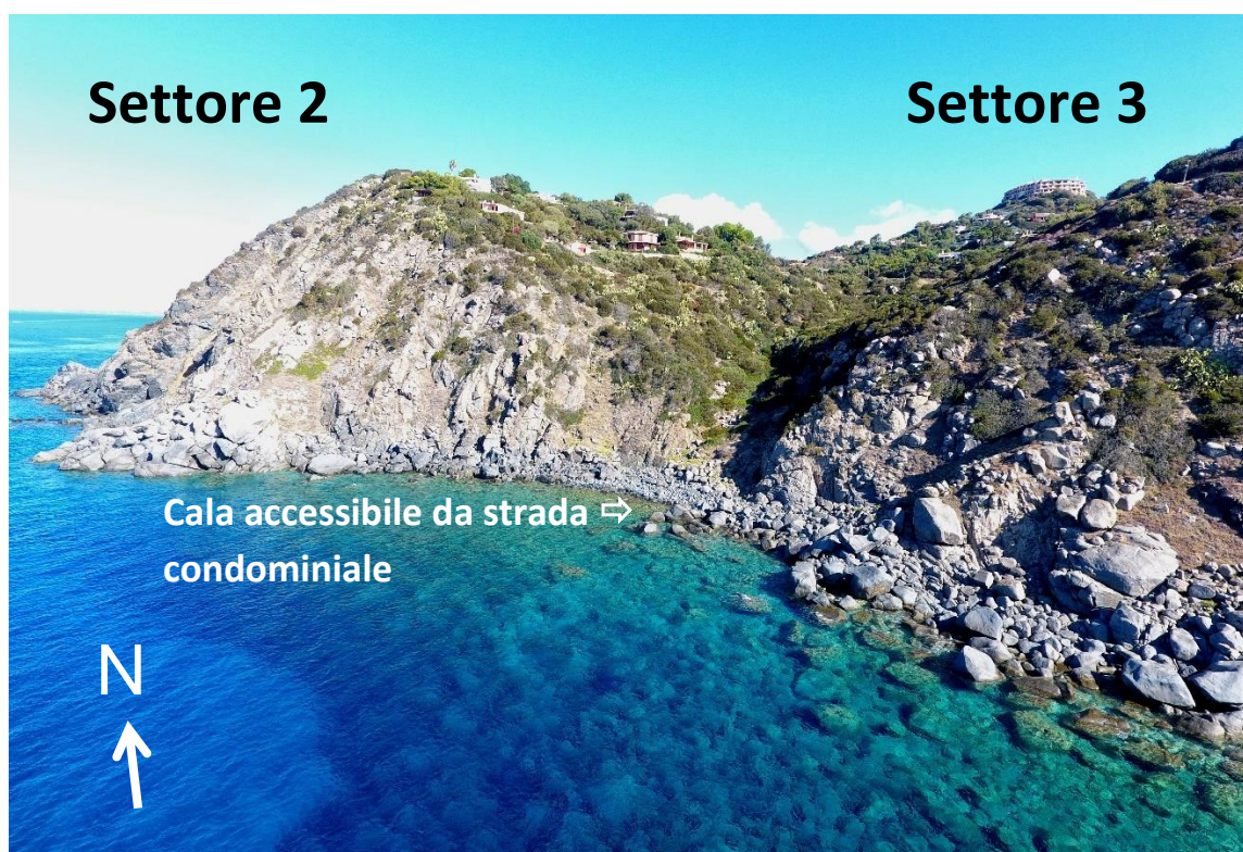
Figura 43 - Settori 2 e 3. Gli edifici presenti sono sufficientemente arretrati e non sembrano interessati da cedimenti determinati dai fenomeni di dissesto attivi.
