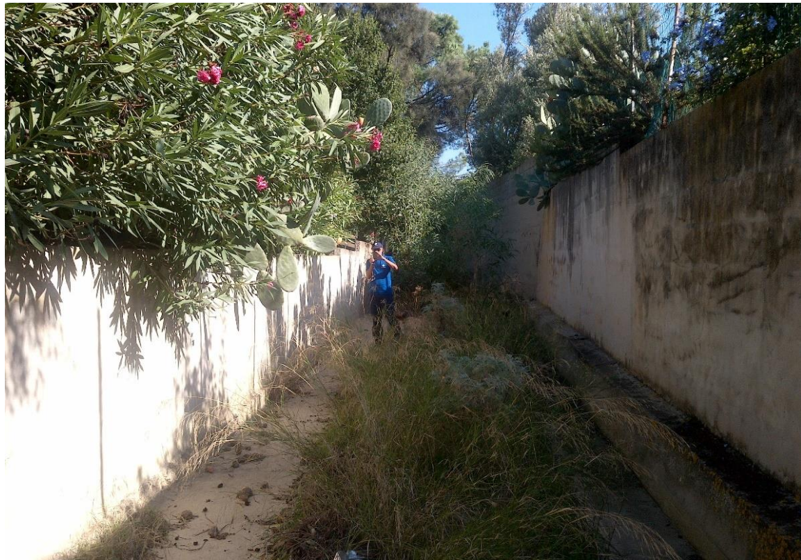
Figura 33 - Obliterazione e totale artificializzazione del canale principale del Rio Gavoi in prossimità della foce e del villaggio di torre delle stelle
