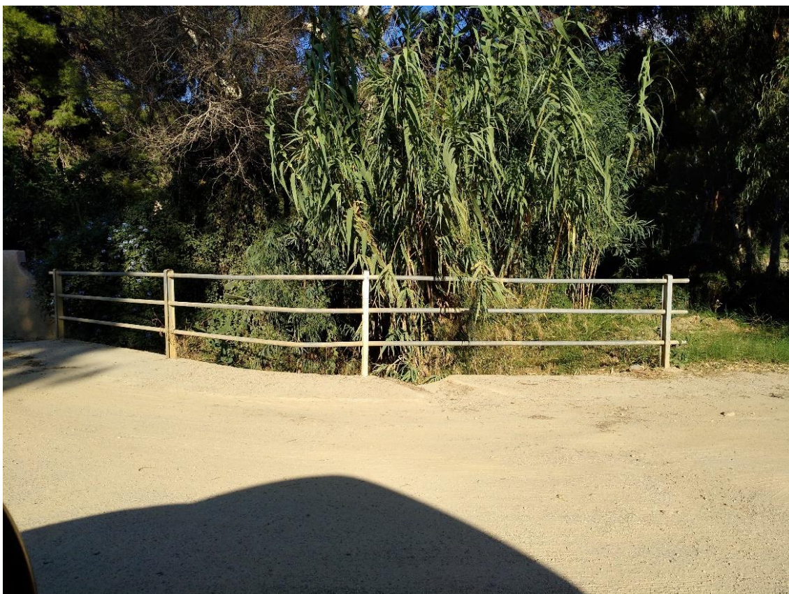
Figura 34 - Il Ponticello sul Rio Gavoi all'interno del villaggio di Torre delle Stelle - Ostruzione
