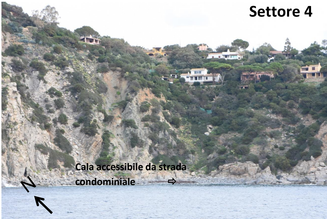
Figura 44 - Settore 4 di Cala Delfino. Alcune costruzioni, nel tempo, potrebbero risentire dei processi di erosione retrogressiva dei versanti a carico del granito arenizzato o dei depositi di versante. La cala è accessibile dalla strada condominiale e frequentata anche da natanti.
