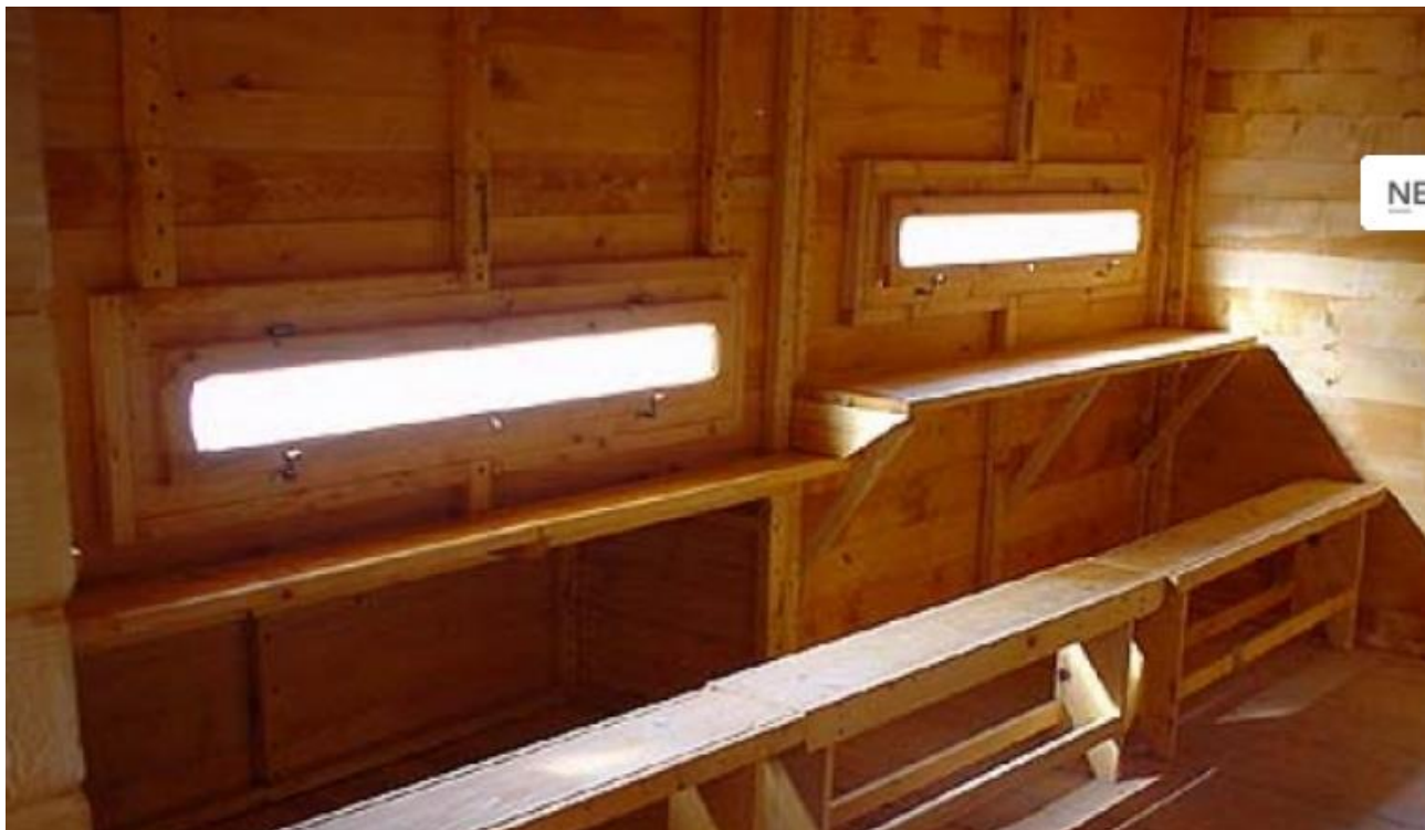
Foto. 9 . Esempio di parte interna di capanno per il birdwatching, completo di finestrelle per l'osservazione, mensole e panche.
