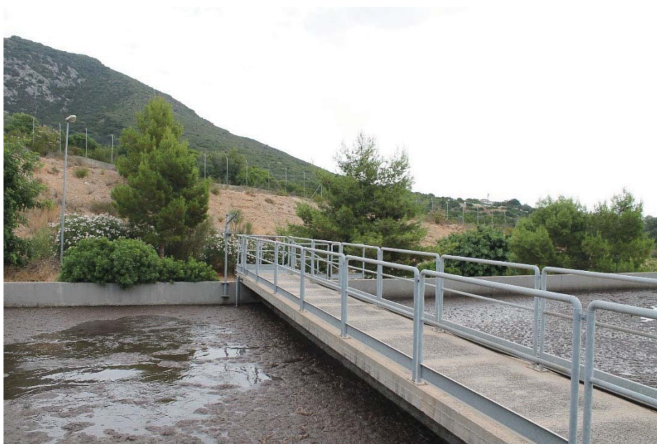
Figura 15 - Denitro e Nitrificazione /ossidazione linea 2 in uso
