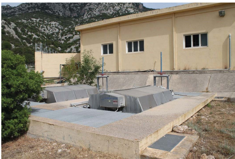
Figura 36 - Filtri per trattamento di affinamento
