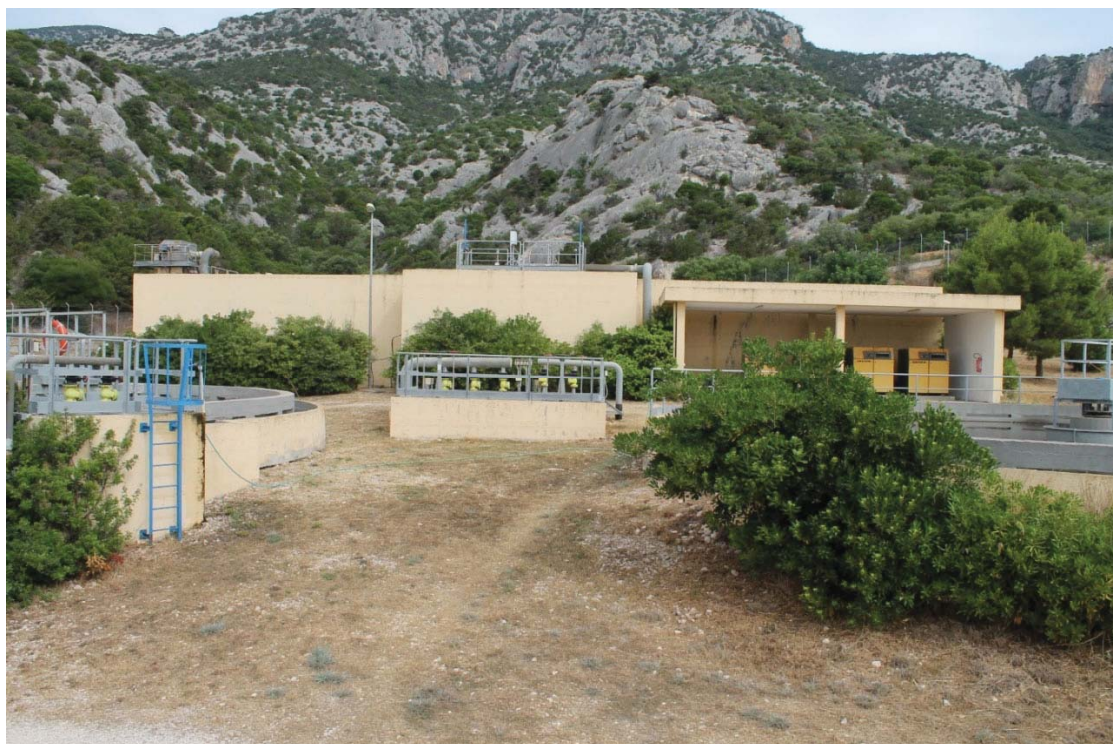
Figura 20 - Vista dei due sedimentatori secondari (ai lati) e la stazione di ricircolo fanghi (al centro)
