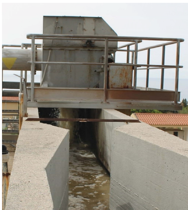
Figura 30 - Rotostaccio e canale di ingresso liquami provenienti dal sollevamento “La Madonnina”
