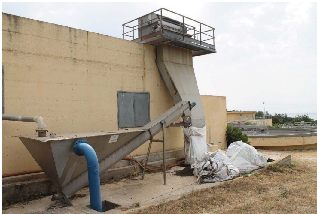
Figura 12 - Esterno Dissabbiatore
