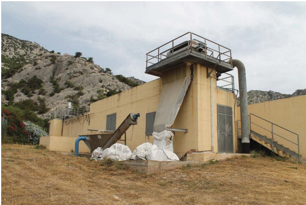
Figura 11 - Arrivo liquame dal sollevamento “La Madonnina”, esterno del Filtro Rotativo a Tamburo esistente e dissabbiatore
