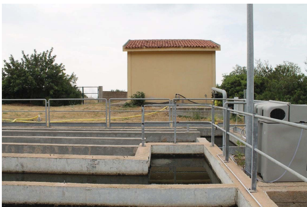
Figura 23 - Labirinto di contatto e punto di prelievo con autocampionatore (a destra)
