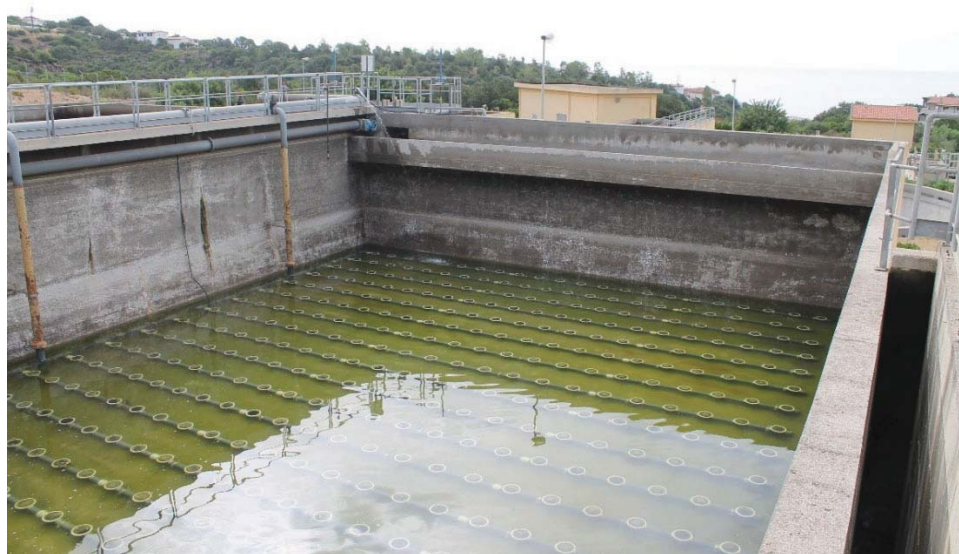
Figura 17 - Vasca di ossidazione linea 1 non in uso al momento dello scatto
