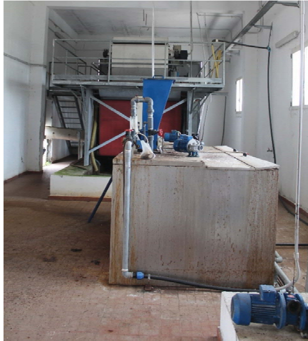
Figura 26 - Nastro pressa con in primo piano la vasca per la preparazione ed il dosaggio del Polielettrolita
