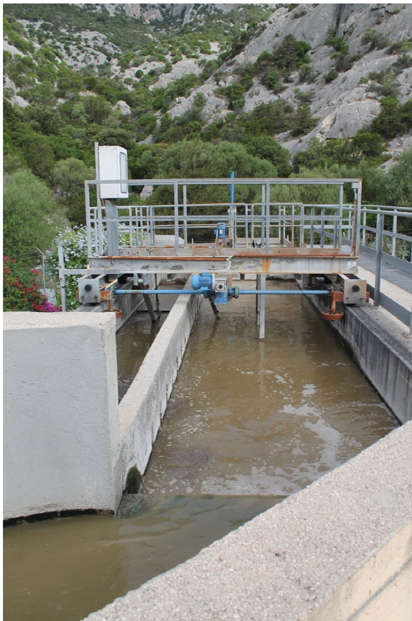
Figura 13 - Canale Dissabbiatore
