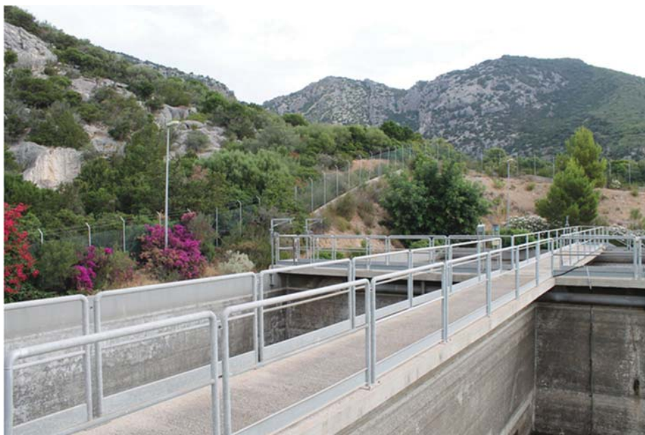
Figura 14 - Vasca di denitro Linea 1 (a sinistra) con setto e passerella di separazione tra denitro e ossidazione
