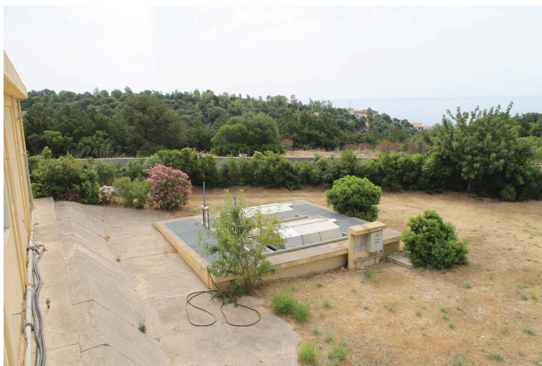
Figura 21 - Trattamento terziario tramite filtrazione vista aerea
