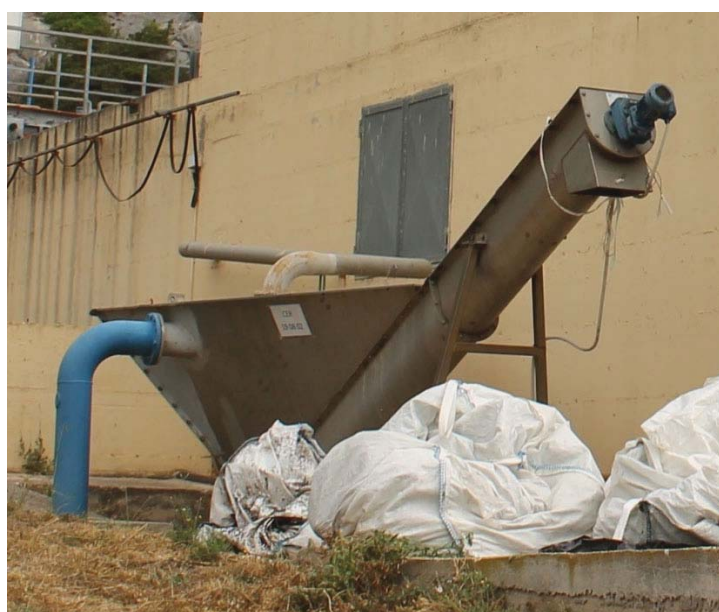
Figura 31 - Apparecchio per il trattamento e l'estrazione delle sabbie
