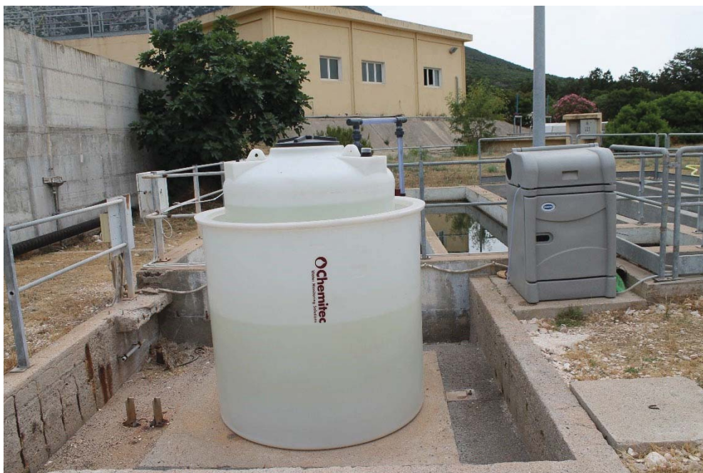
Figura 24 - Labirinto di contatto Serbatoio stoccaggio Ipoclorito con autocampionatore (a destra)
