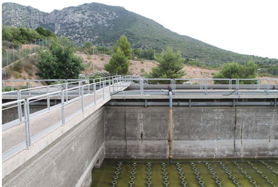
Figura 16 - Vasca Denitro (a sinistra) e apertura di collegamento con Nitro/ossidazione linea 2 (non in uso al momento dello scatto)
