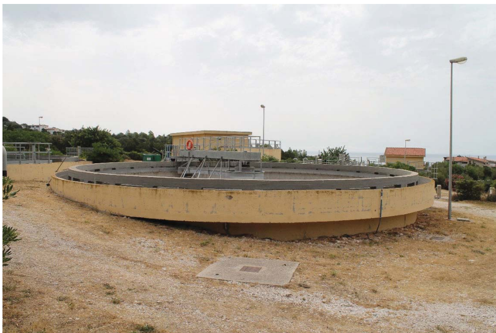
Figura 18 - Sedimentatore secondario linea 1
