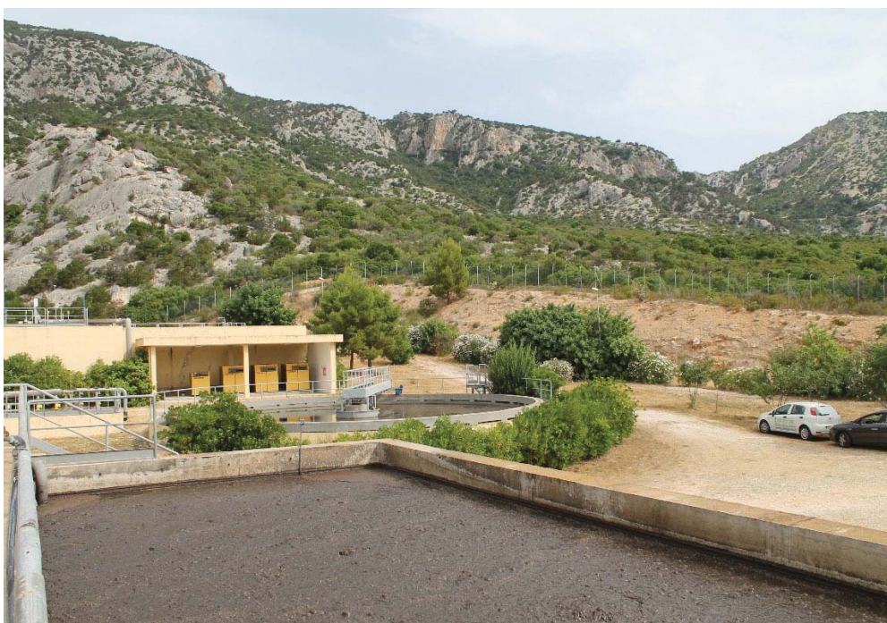
Figura 25 - Vasca stabilizzazione fanghi, con sedimentare secondario e ambiente compressori in lontananza
