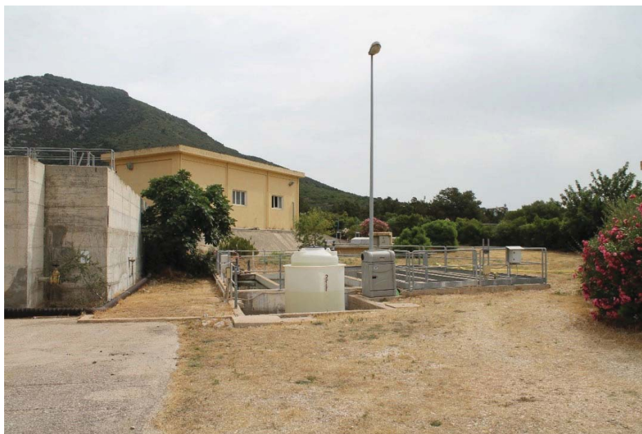
Figura 35 - Labirinto di contatto, cloratore e autocampionatore
