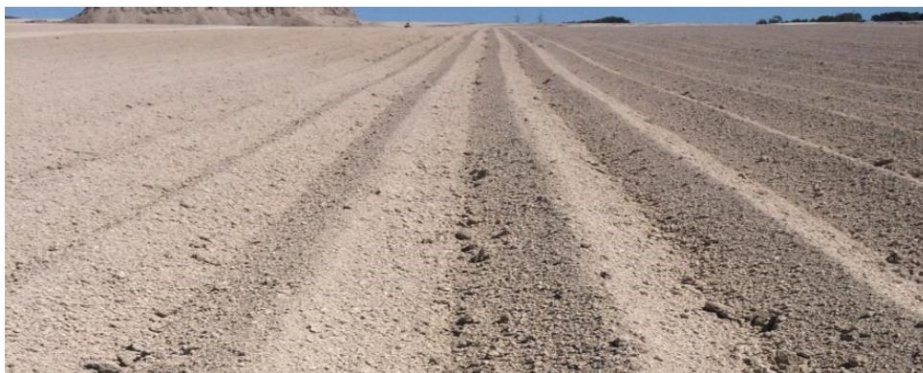
Trattamento con mezzi agricoli finalizzato alla riduzione granulometrica
