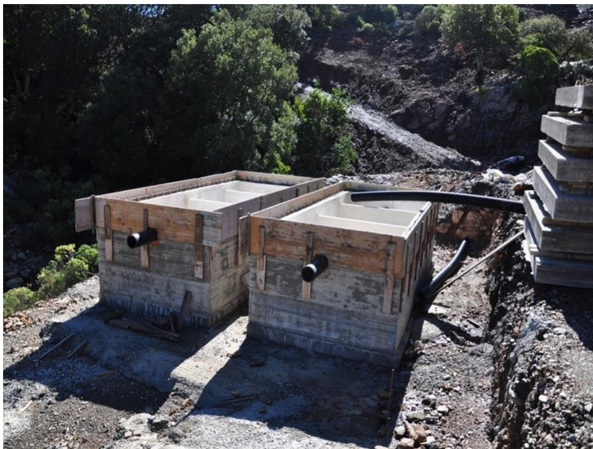
Figura 6.3-2: Acque vasche per trattamento passivo effluenti contaminati
