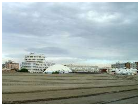
Figura IV.2.3.1.5- esempio di argine di protezione invernale correttamente eseguito
