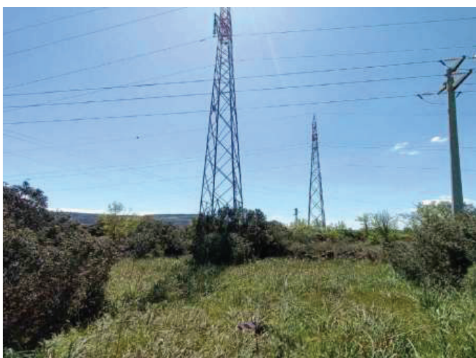
Ambito presso il sostegno n. 4. Si nota la presenza sull'area aperta di altre linee di elettrodotto.
