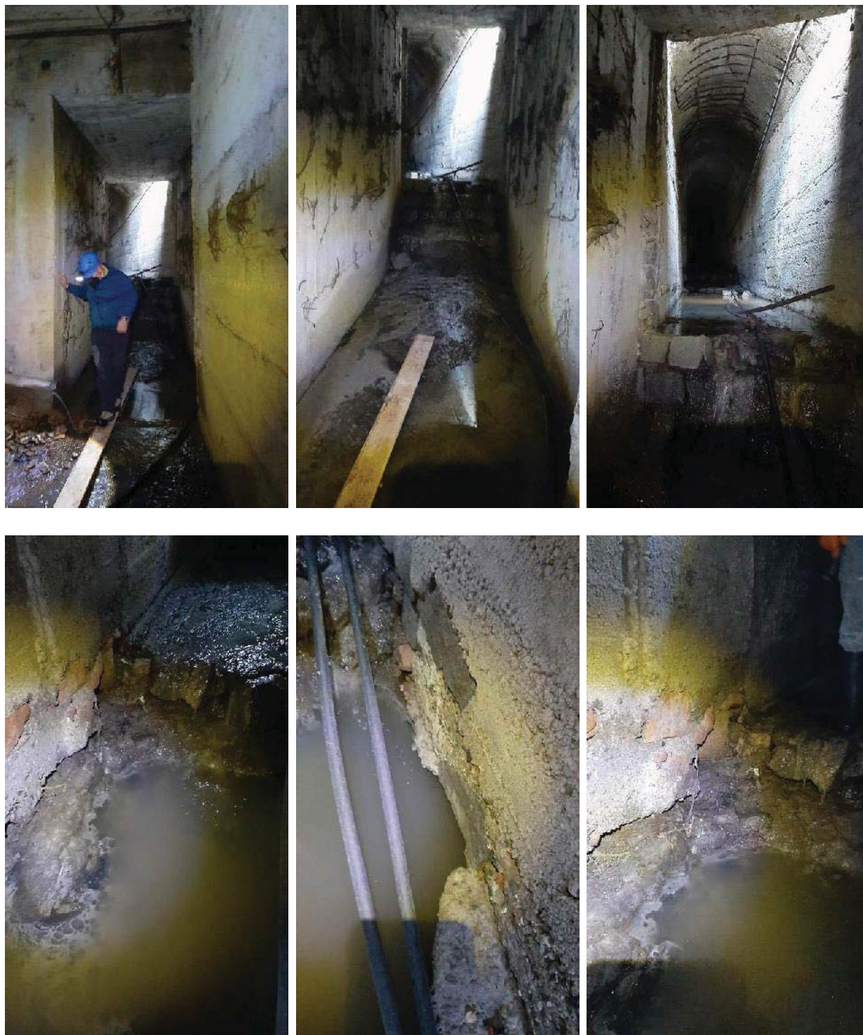
Figura 22 – Immagini interne nel tratto del Rio Monti Sperrau sottostante la piazza a valle della confluenza in prossimità della spalla sinistra del Ponte “Marcia”; Particolari della buca erosiva sul fondo canale
