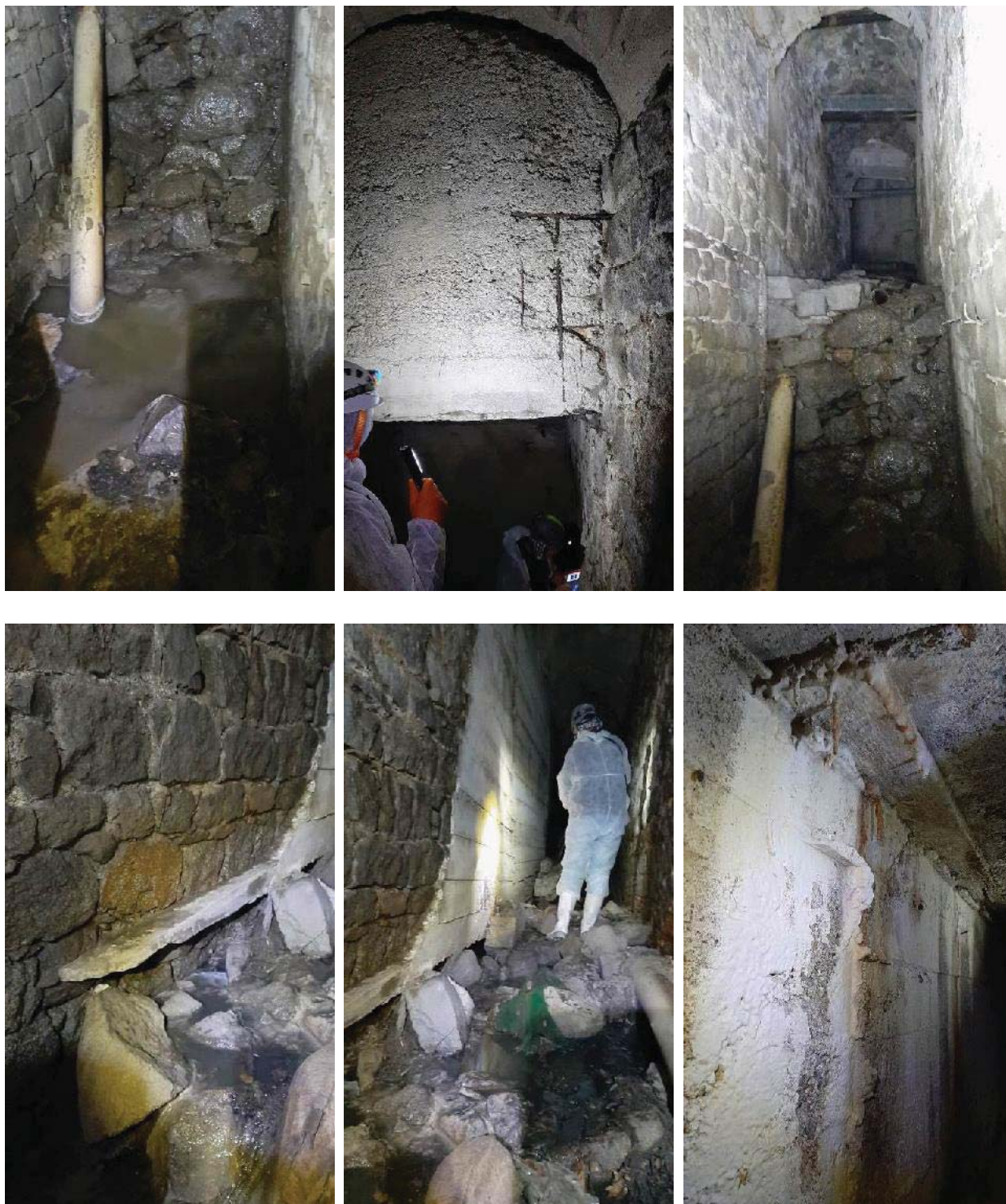
Figura 26 - Immagini interne al Rio Monti Sperrau; particolari della forte erosione presente sul fondo del canale
