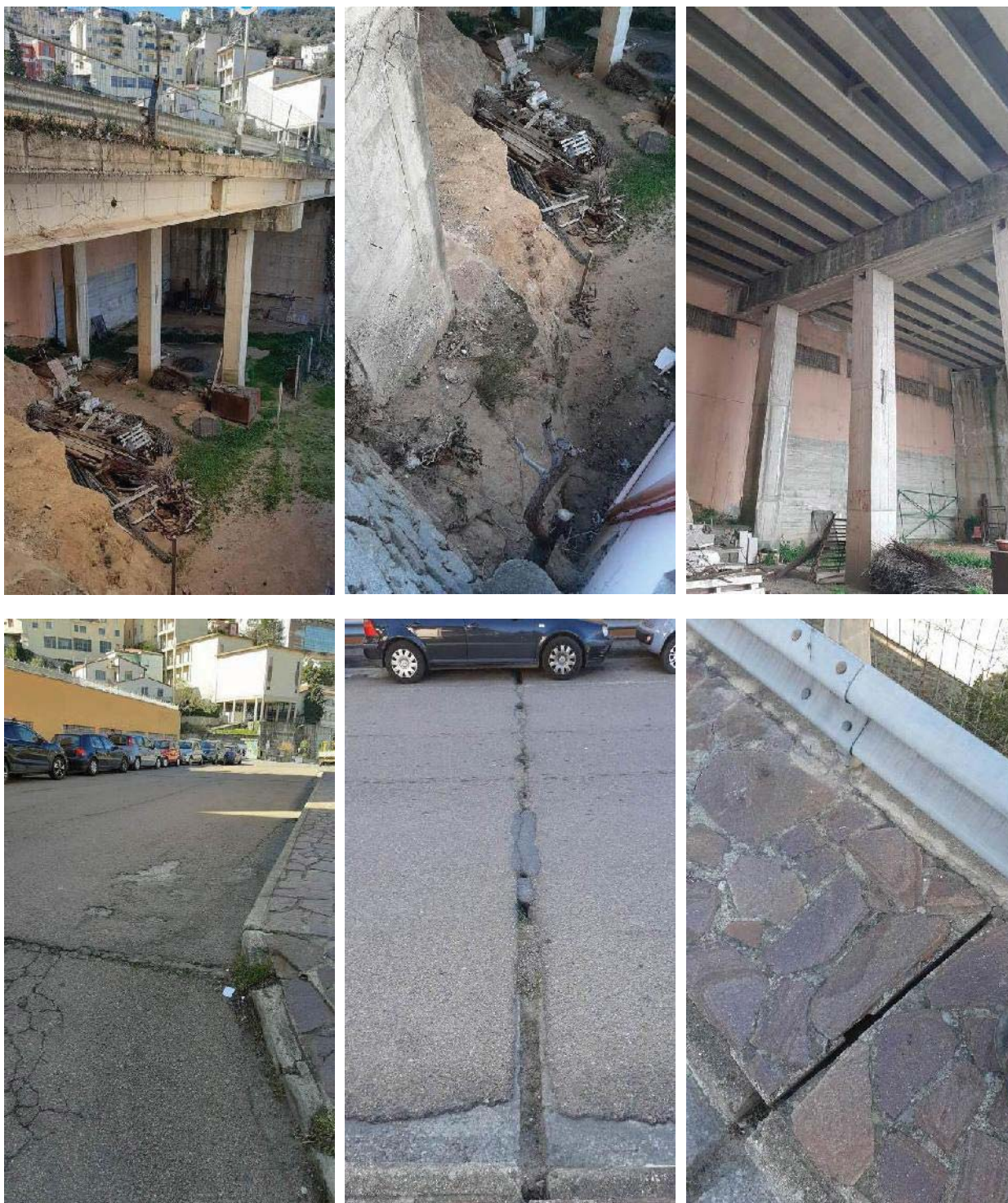
Figura 19 – Alcune immagini dell'impalcato del Ponte "Marcia" e dei danneggiamenti sul piano stradale
