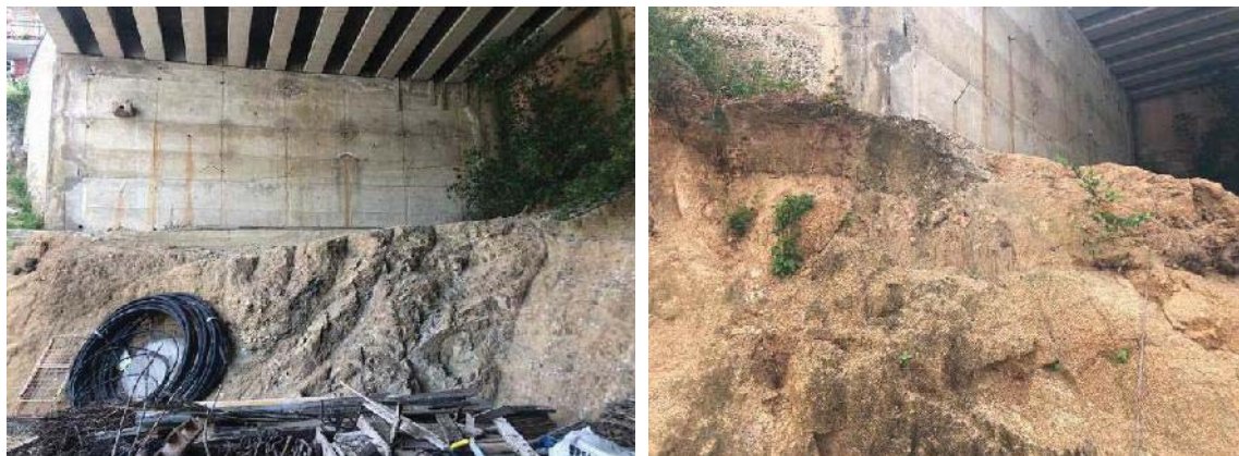
Figura 4 – Immagini riprese a valle del ponte, in corrispondenza della pila in destra idraulica. I terreni di appoggio sono costituiti da granito lapideo, in prevalenza compatto.
