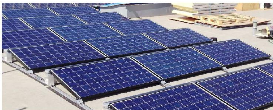
Fig. 11 – Dettaglio delle modalità di posa su cavalletto dei pannelli FV a tetto
