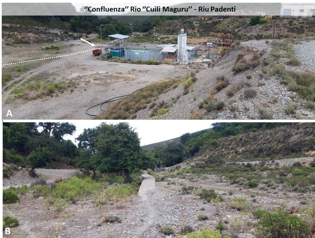
Figura 27: porzione terminale del Rio. In A. è evidenziato il percorso tombato del rio e la freccia indica un pozzetto di ispezione all'interno del quale recapitano anche le acque in uscita dal depuratore (le strutture ben evidenti al centro dell'immagine). In B la porzione terminale del tratto tombato poco prima dell'immissione nell'impluvio del Rio Padenti.
