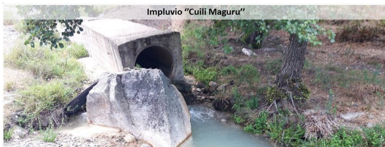
Figura 28: sbocco di valle del tratto tombato del Rio; l'acqua che esce è costituita quasi esclusivamente dal contributo del depuratore, recapitante al momento del rilievo circa 15 l/s.
