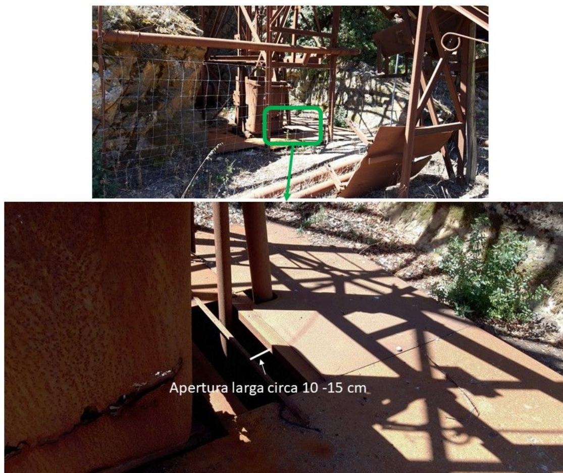
Figura 20: immagini dell'accesso al vecchio pozzo di Muscadroxiu (attualmente in disuso) utilizzato dai pipistrelli per l'accesso al sotterraneo. La fessura evidenziata è l'unica utilizzabile: si suggerisce di sostituire la lastra a sx della fessura indicata con una grata con sbarre orizzontali di interasse 8 cm.
