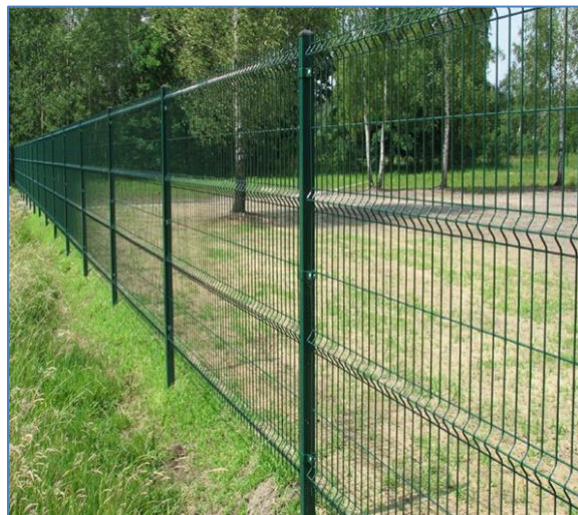
Figura 4. Esempio di recinzione perimetrale con pali ad infissione nel terreno senza utilizzo di plinti in cemento
