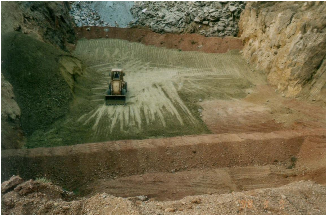
Vista 2 - Lavori di impermeabilizzazione del fondo della discarica
