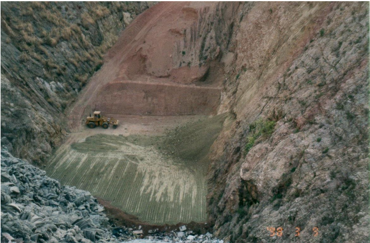
Vista 1 - Lavori di impermeabilizzazione del fondo della discarica
