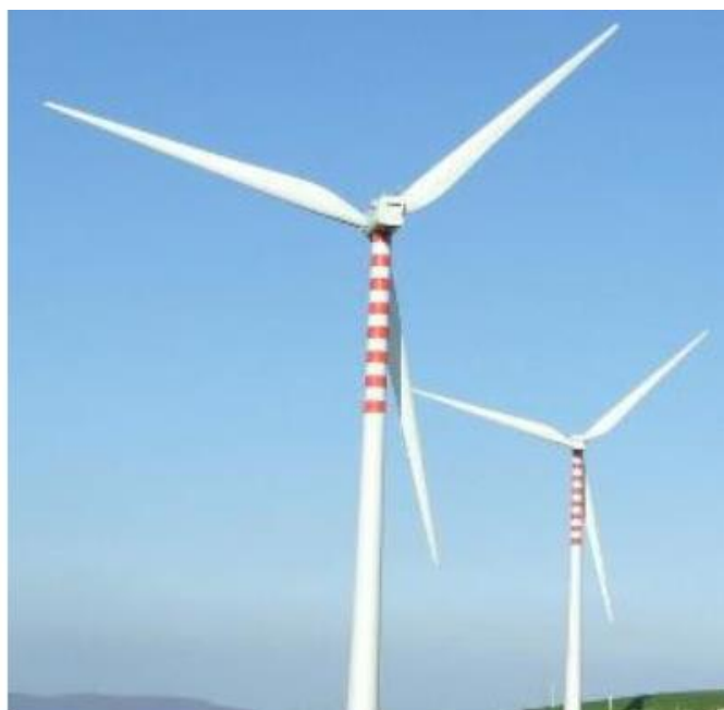
Figura: esempi di segnalazione diurna per turbine eoliche, sulle pale o sulla sezione finale della torre
