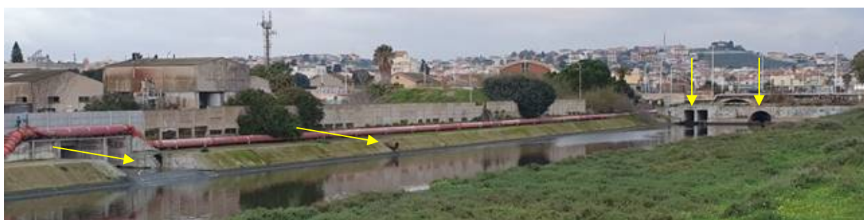
Figura 2.6- Vista del Canale di Terramaini dalla sponda sx verso nord-ovest: in senso antiorario l'immissione del Rio Saliu e della serie di scarichi fognari di Pirri, nell'ordine dei due collettori C70, del collettore C47' e dei due collettori 38 a e b.
