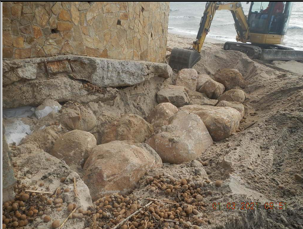
Fig. 34 – Particolari dell' Intervento di difesa aderente in fase di realizzazione a Marzo 2021
