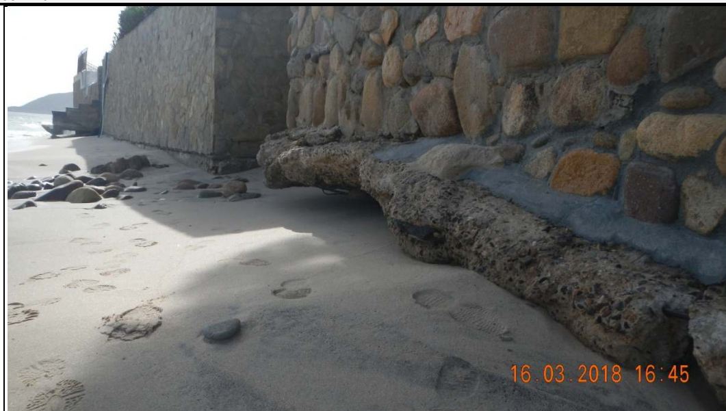
Fig. 32 -Scalzamento della fondazione del muro
