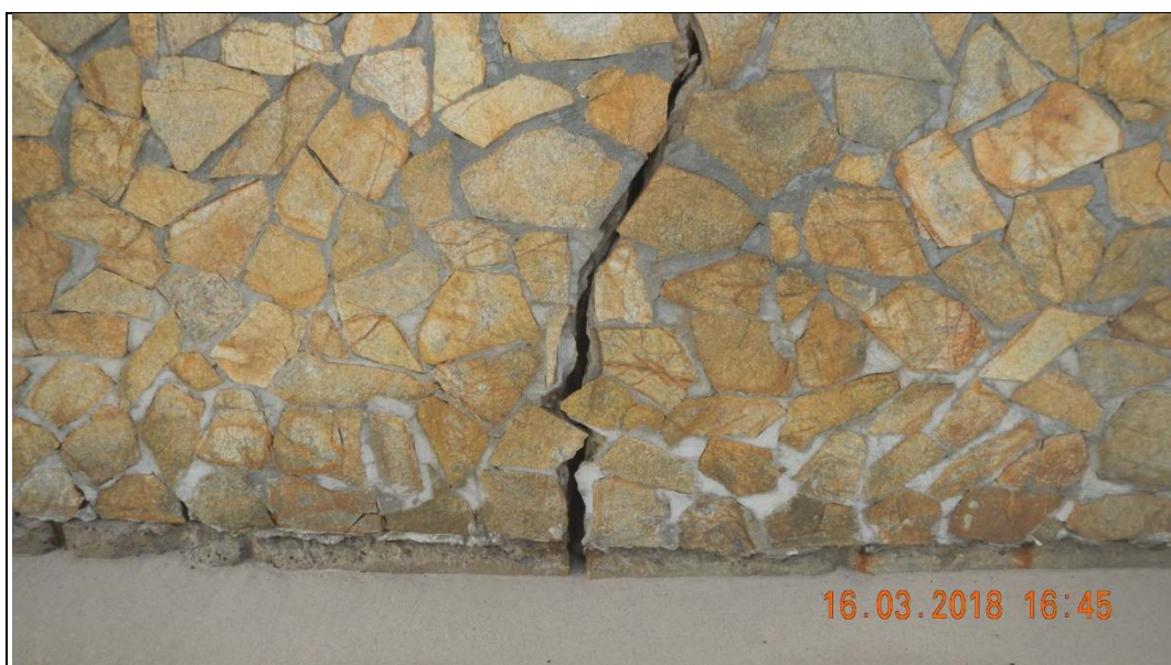
Foto 31- Ulteriori danni strutturali al muro che delimita la struttura turistica
