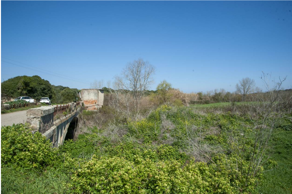
Figura 3: foto del tratto stradale di attraversamento del Rio Ertas nel punto di confluenza con il Rio Mannu : il cavidotto sarà posato tramite TOC in modo da non determinare alcuna interferenza con il corso d'acqua.
