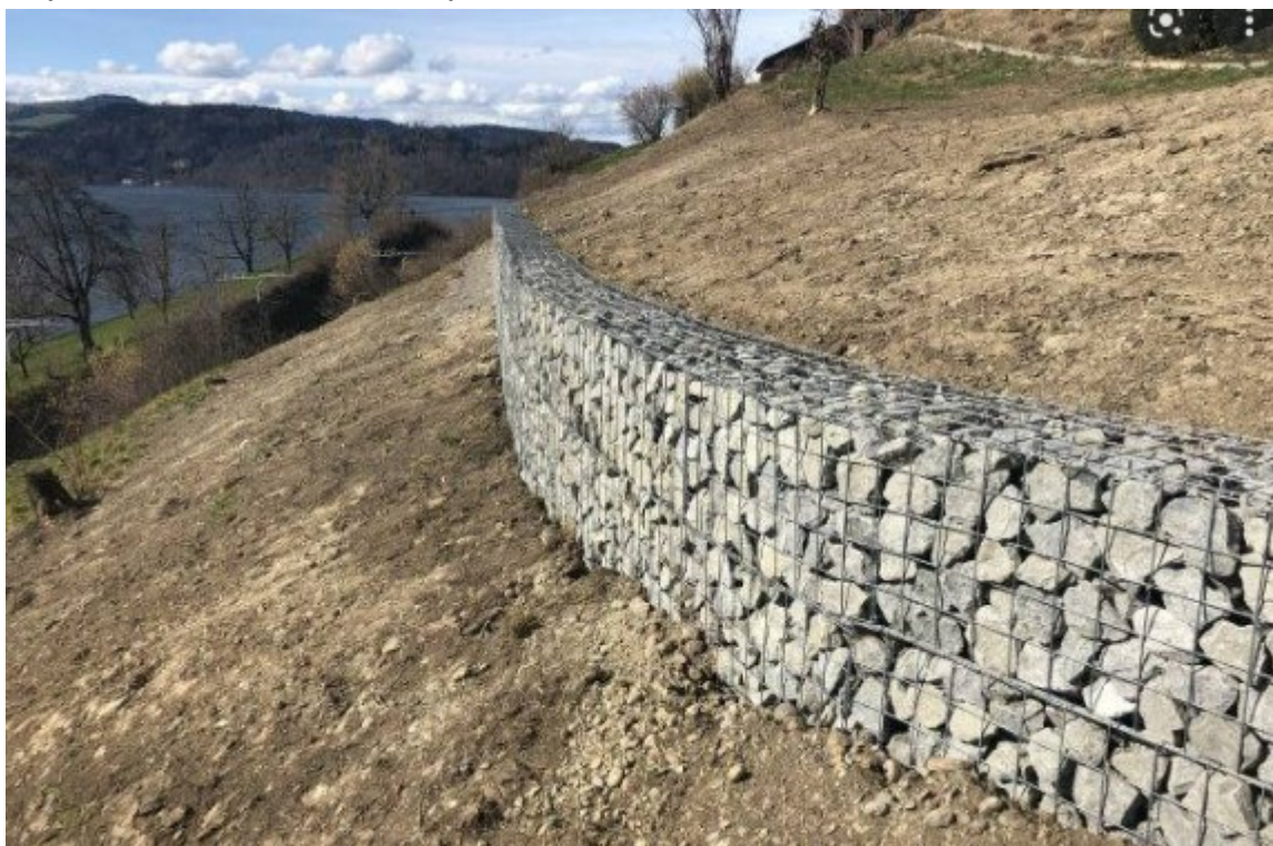
Figura 4 – Muro in gabbioni
