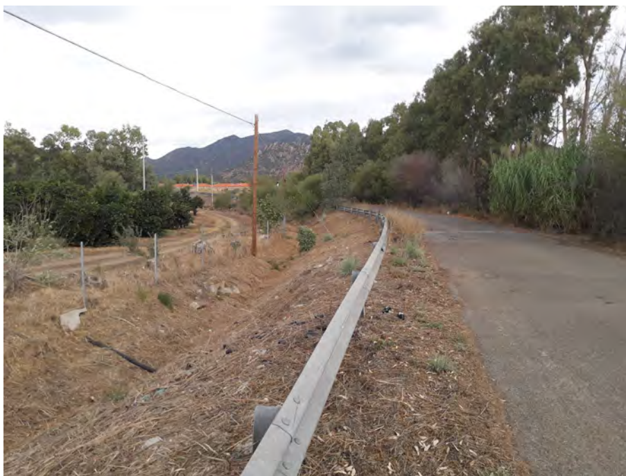
FOTO 2: tratto di cunetta stradale oggetto di sistemazione: verrà realizzato un canale a cielo aperto di sezione trapezia opportunamente dimensionato per la portata afferente al bacino sotteso
