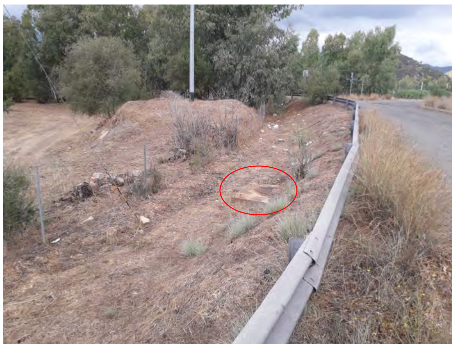
FOTO 1: sito con tombino del sifone (in evidenza) che permette l'attraversamento della sede stradale della SP 20; da questo punto si procede con i lavori di realizzazione del canale dentro la ZPS
