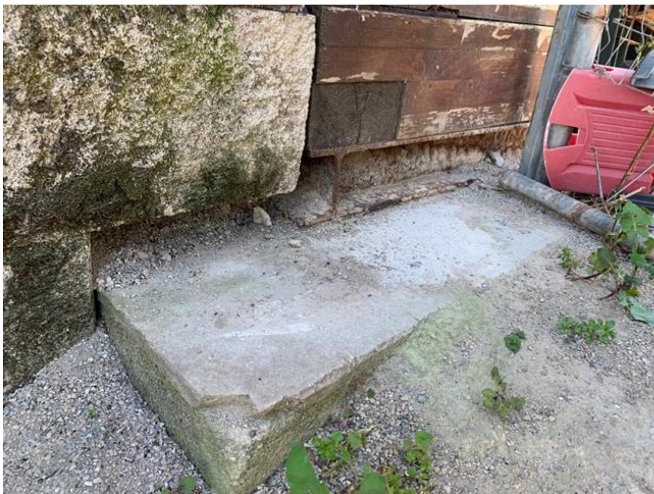
Figura 2.2 –Uno dei plinti di sostegno alle strutture prefabbricate
