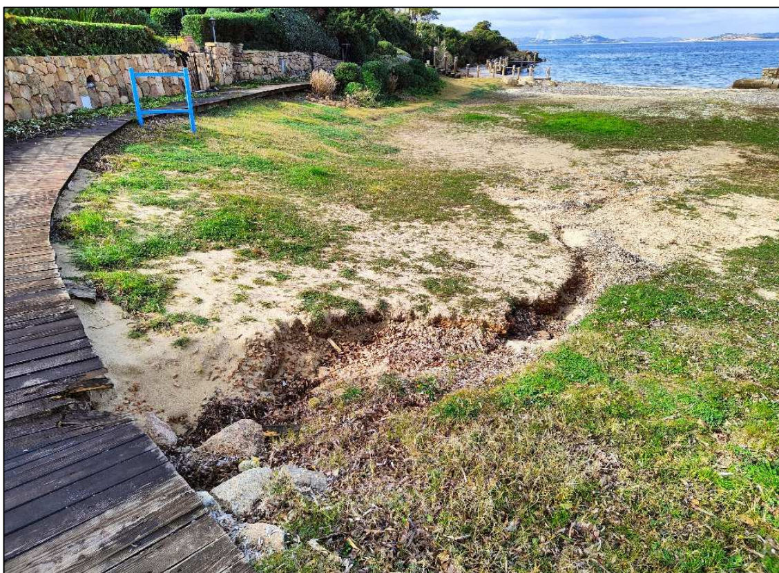
Figura 11 – Incisione ad opera delle acque di corrivazione alla base della scalinata ed esposizione dei sottostanti clasti a spigolo vivo.
