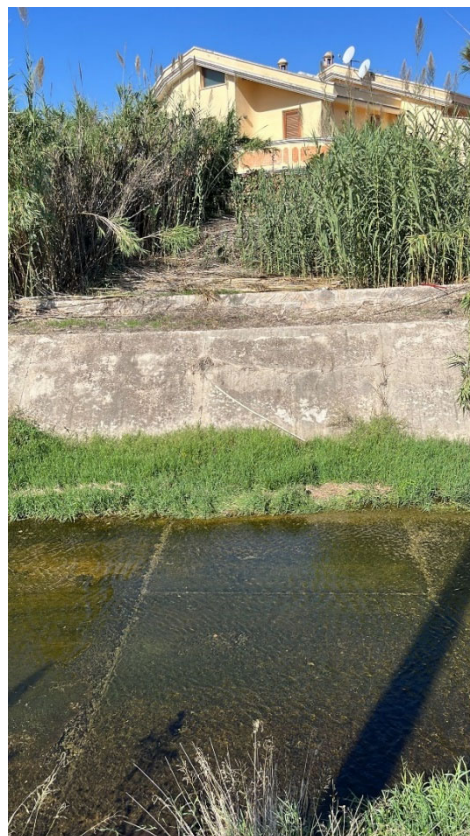
Dettaglio fondo e sponda rivestiti in cls
