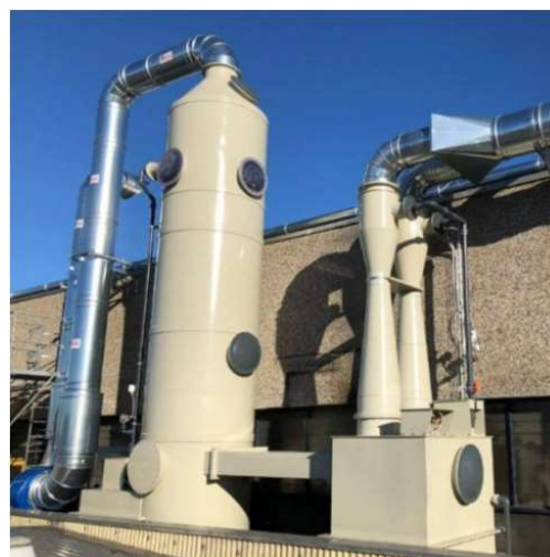
Figura 25 Esempio di torre Scrubber (fonte: Coral)
