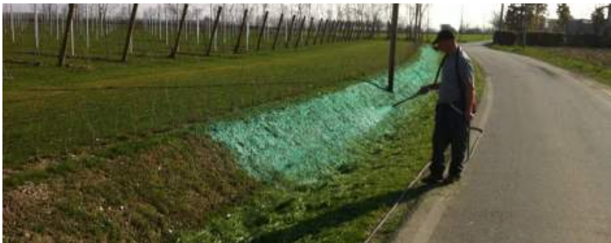
Figura 155 - Sistema di idrosemina
