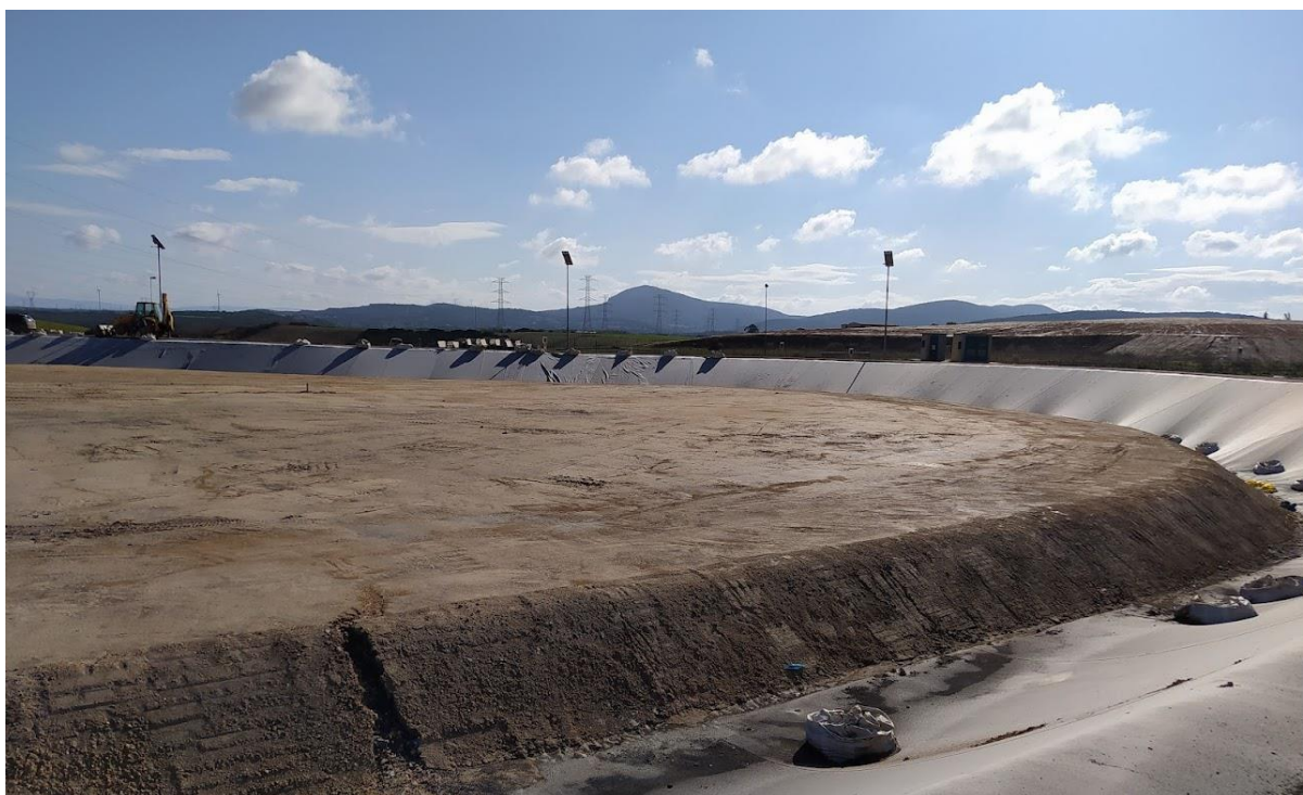
Figura 14- Particolare impermeabilizzazione sponde Modulo 3 in corrispondenza del marcapiano
