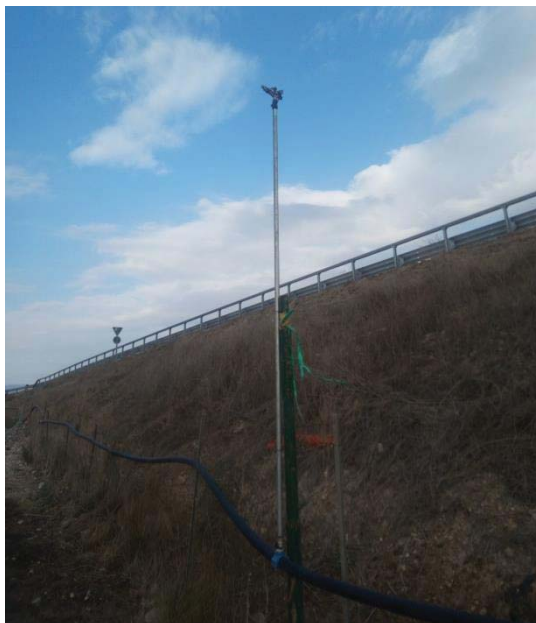
Figura 15 - nebulizzatori installati lungo il perimetro dello stabilimento per l'abbattimento delle polveri
