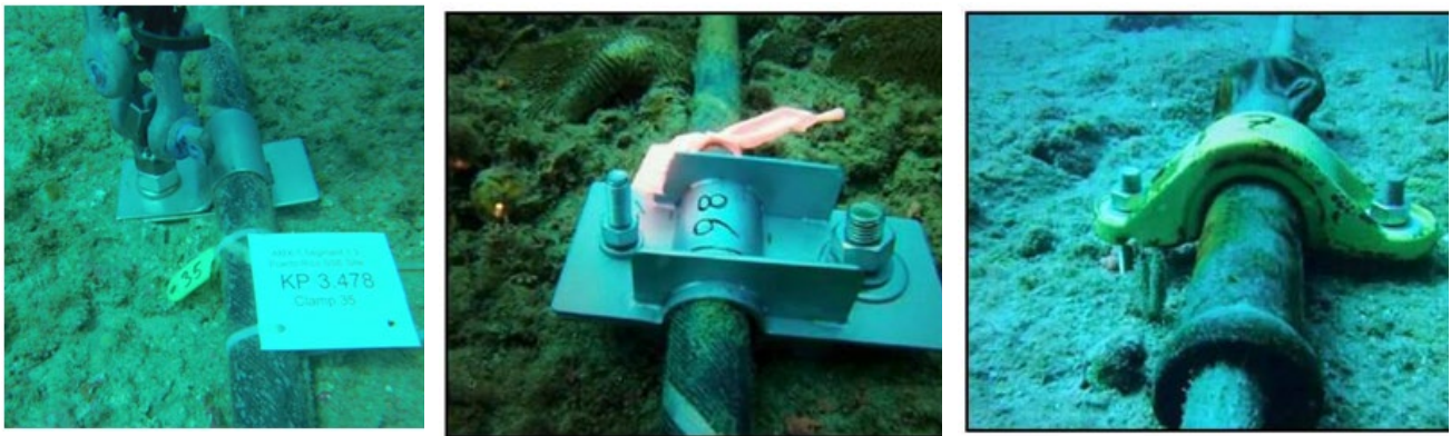
Figura 11 - Tasselli di acciaio Inox su roccia; morsa a 1 barra e a 2 barre.
