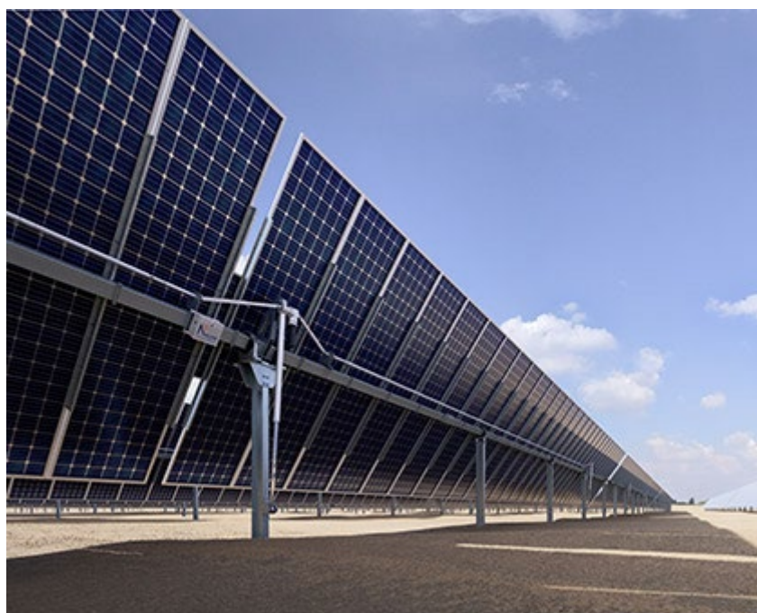
figura 4 – Esempio di moduli installati su inseguitore ad asse orizzontale
