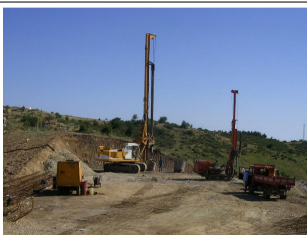
Realizzazione pali trivellati
