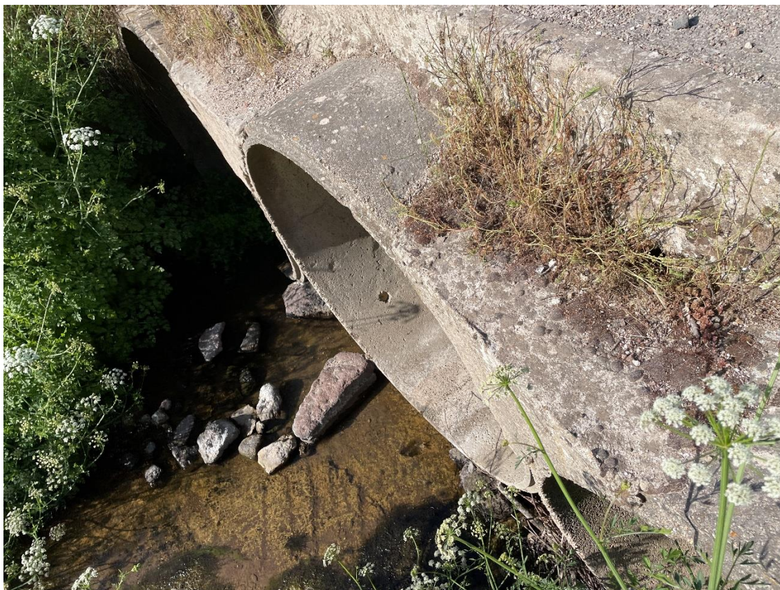
Figura 4.17: Esempio di interferenza idraulica con la viabilità di accesso alle torri SDN01, SDN02, SDN03, SDN04.
