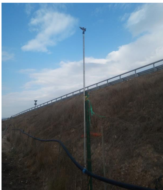
Figura 20 - nebulizzatori installati lungo il perimetro dello stabilimento per l'abbattimento delle polveri
