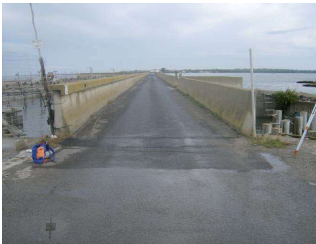
Figura 2. Stato attuale della struttura interessata dall'intervento
