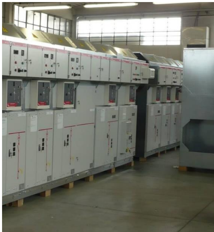
Figura 38 Esempio di quadri di raccolta cavi a 36KV, da interno.
