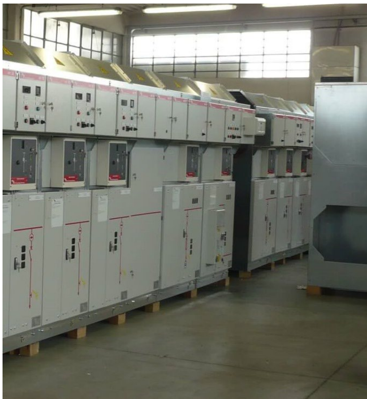
Figura 66: Esempio di quadri di raccolta cavi a 36KV, da interno.
