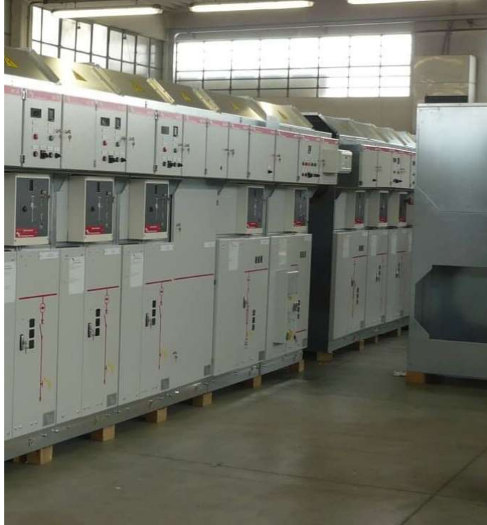
Figura 10 Esempio di quadri di raccolta cavi a 36KV, da interno.
