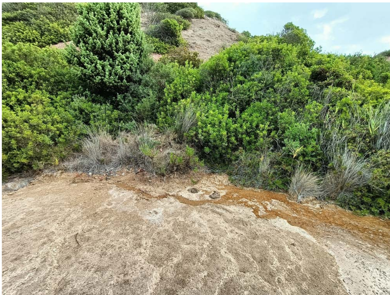
Uno dei punti di scaturigine delle acque percolanti dal piede dell'argine meridionale del Bacino 8
