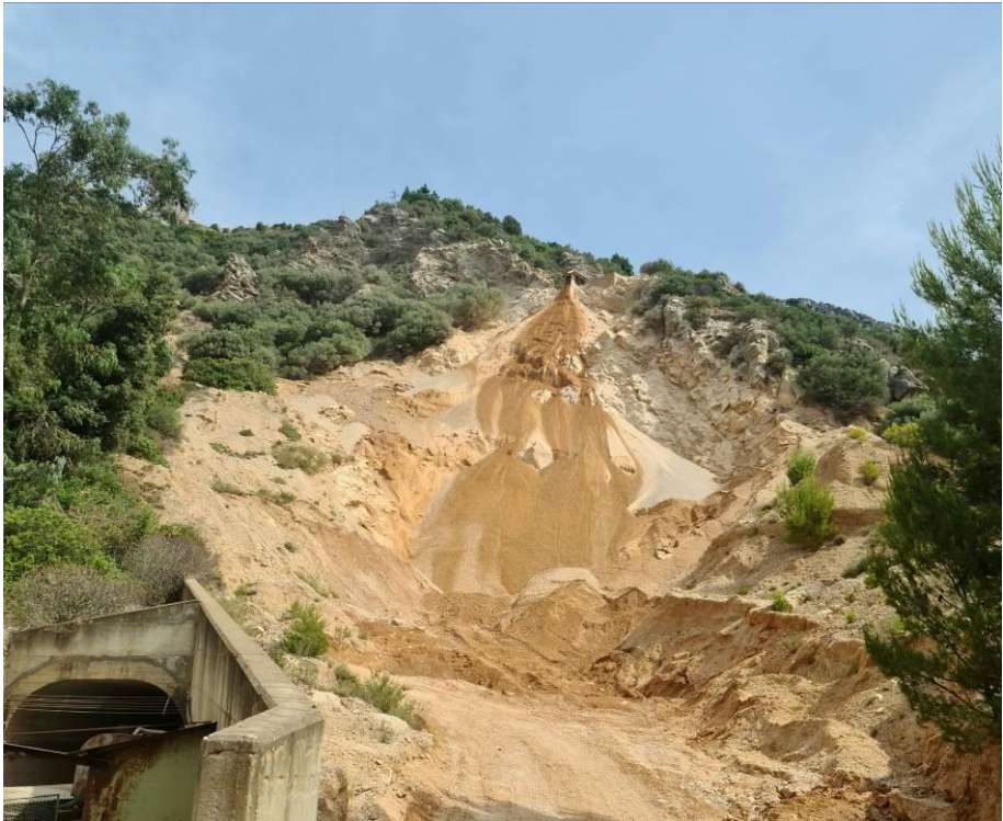
Figura 4 – la conoide di gettito allo stato attuale con il materiale che scende lungo la parte centrale lasciando libere le superfici laterali
