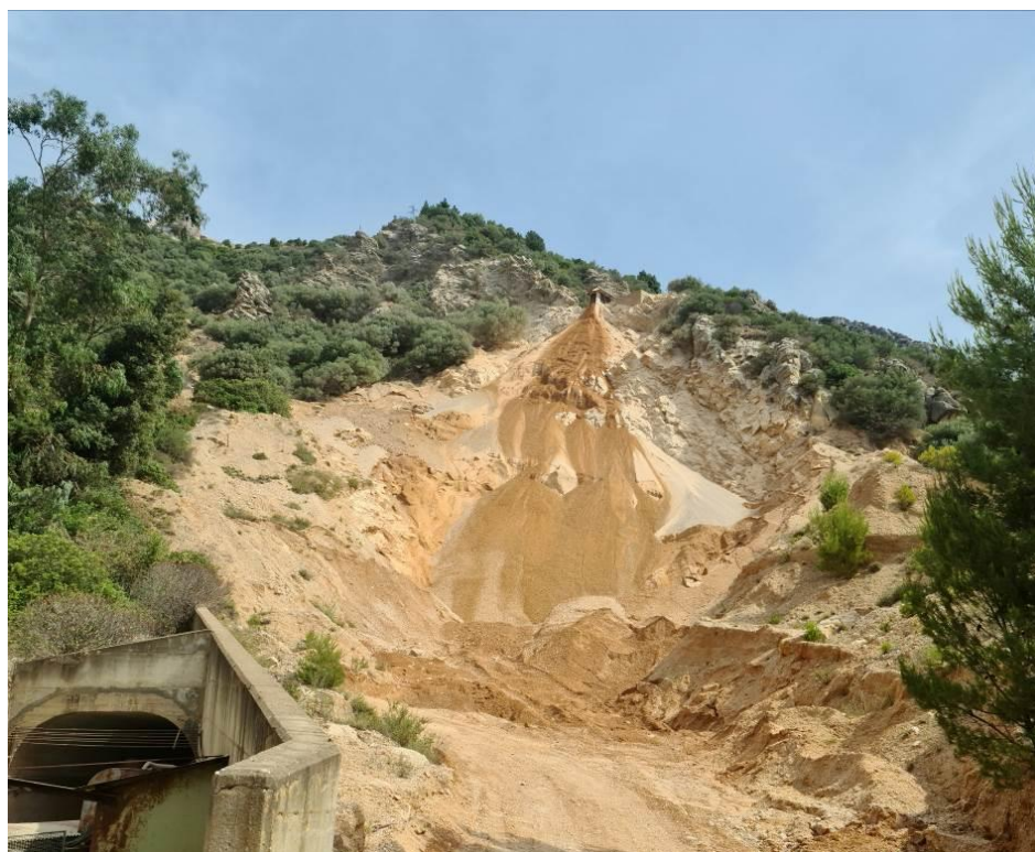
Figura 3 – Visuale 1 - la conoide di gettito allo stato attuale con il materiale che scende lungo la parte centrale lasciando libere le superfici laterali
