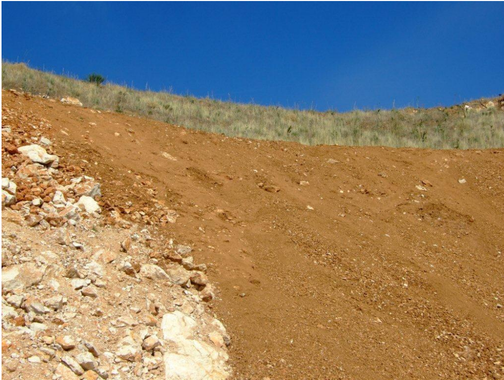
Figura 25 – Terreno miscelato e appena steso su una scarpata di gradone in cava Sas Funtanas.
