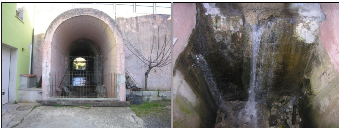
Figura 9. Sulla sinistra il ponte sul Corso Vittorio Emanuele, sulla destra il pozzetto posto alla fine che immette al canale tombato
