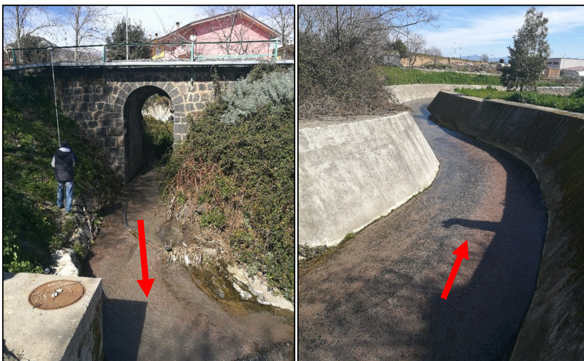
Figura 12. Sulla sinistra l'attraversamento sulla linea ferroviarie, sulla destra il tratto a pelo libero a valle dell'attraversamento
