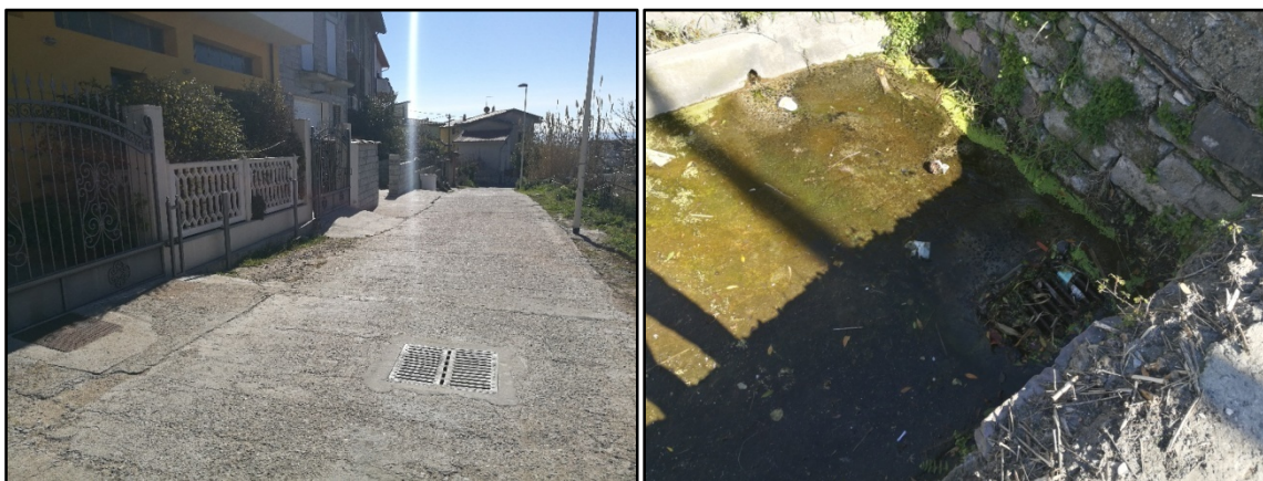
Figura 13. Nella foto a sinistra caditoia stradale per l'immissione delle portate che scorrono sopra la soletta del canale, sulla destra foto di una caditoia che confluisce le acque delle aree adiacenti
