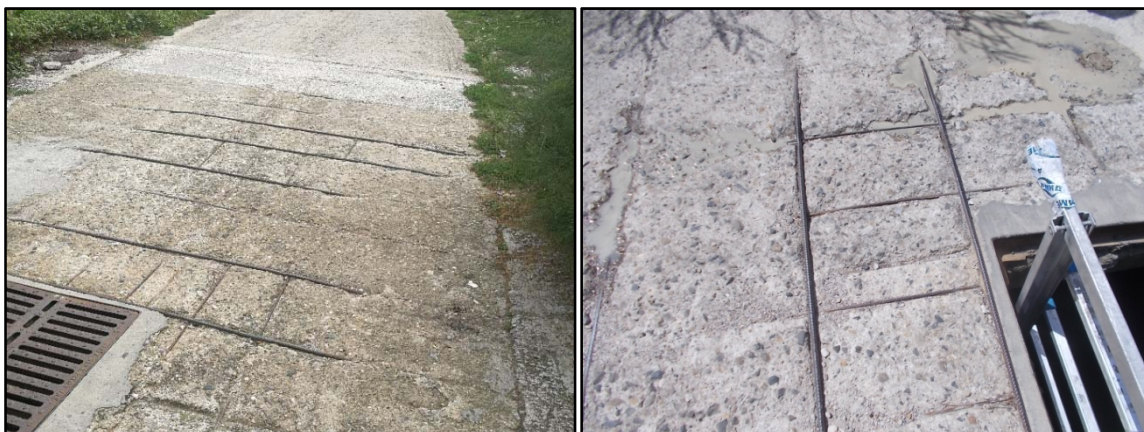
Figura 14. Parte superiore della copertura con evidenti segni di usura
