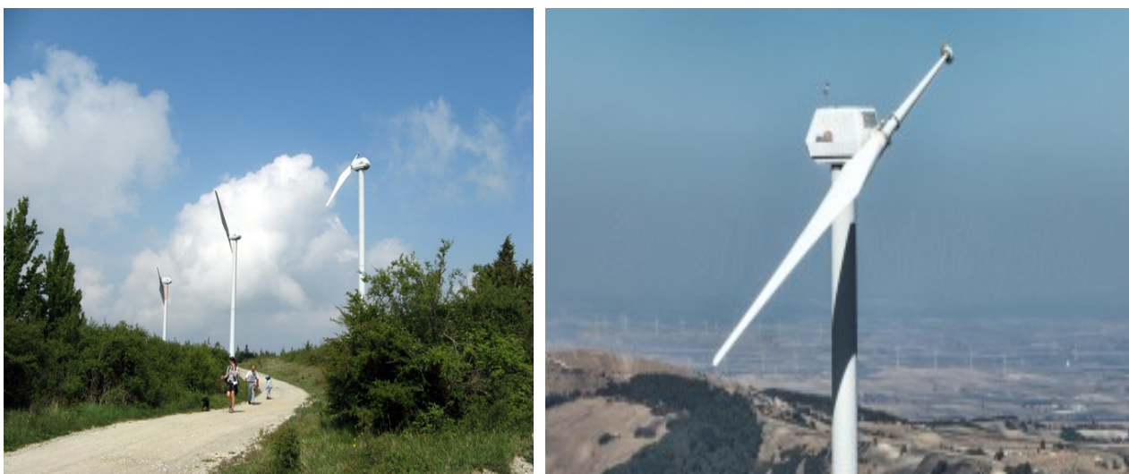
Fig. 4. Immagini del vecchio parco eolico e primo piano di una turbina Riva-Calzoni da 320 kW di potenza.
