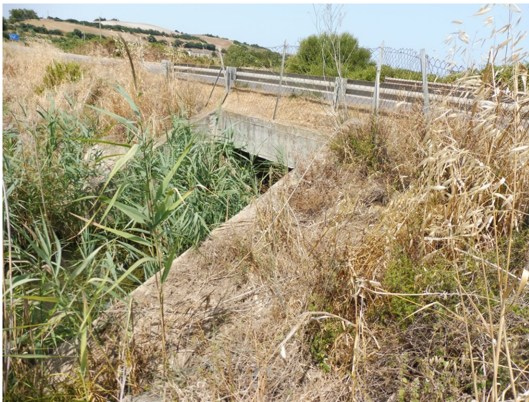
Foto 01- Vista dell'attraversamento sulla S.P. 33 a monte del quale si interrompe l'intervento di adeguamento del canale a cielo aperto previsto.
