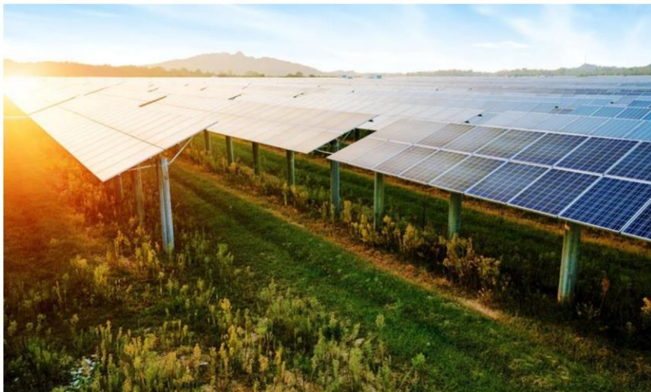
Figura 4-4: Esempio di struttura di tipo mobile (tracker) mono-assiale con configurazione 1p
