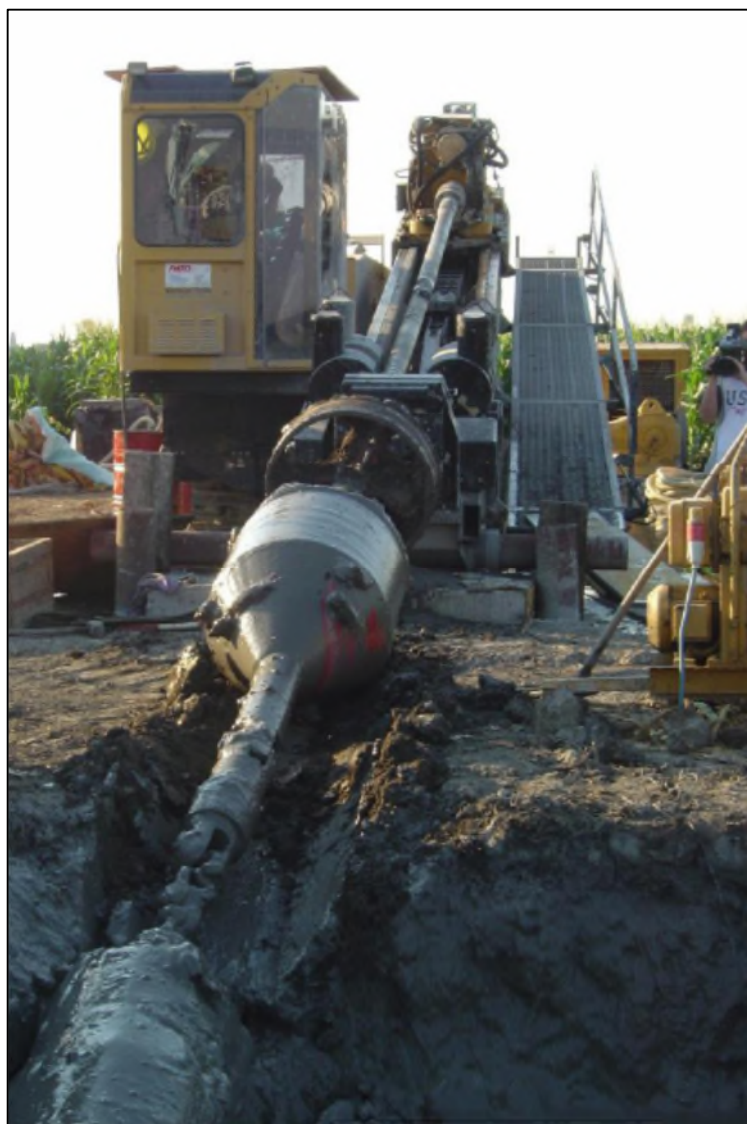
Figura 24 - Varo di una condotta mediante T.O.C.
